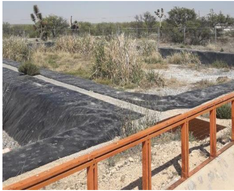
Figura 38. Vista exterior actual de PTAR AO
