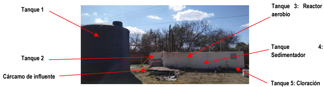
Figura 28. Vista exterior actual PTAR FAV
