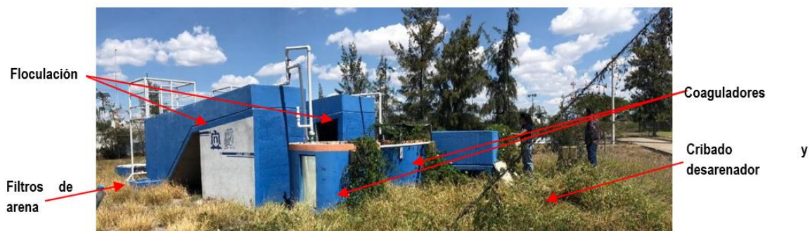
Figura 52. Vista exterior actual PTAR ZM
