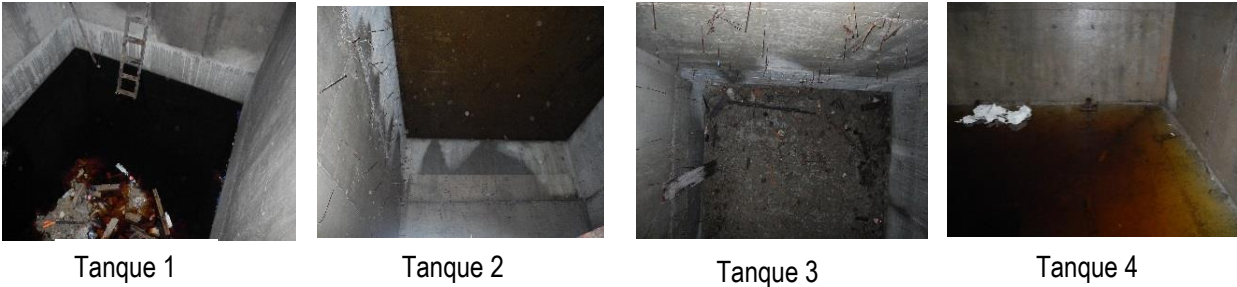
Figura 14. Vista interior actual PTAR ZUP
