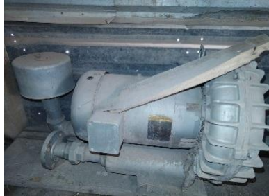
Figura 27: Soplador de PTAR FAV
