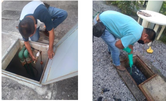
Figura 63. Mantenimiento preventivo a (A) sistema de agua entubada y a (B) drenaje (Agenda Ambiental, 2022)
