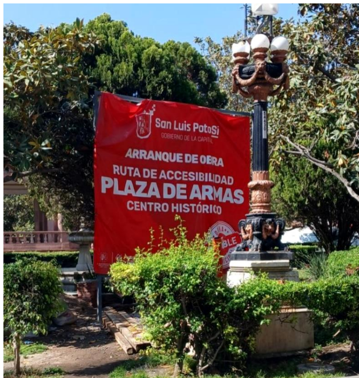
Figura 6. Plaza de Armas, arranque de obras. Autoría propia.
