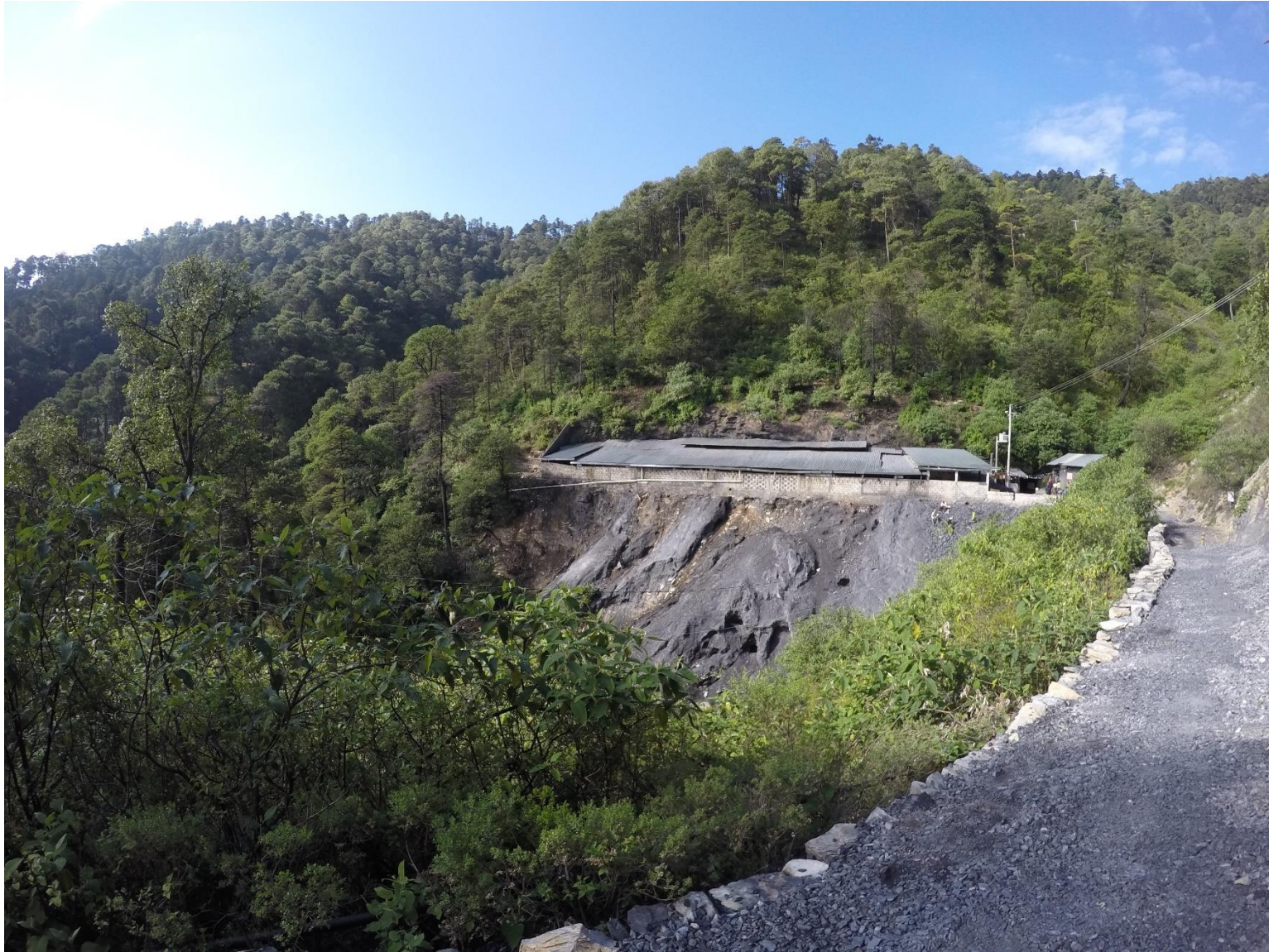
Fig. 4 Mina de mercurio La Soledad, San Gaspar, Pinal de Amoles, Querétaro (Fuente: elaboración propia)
