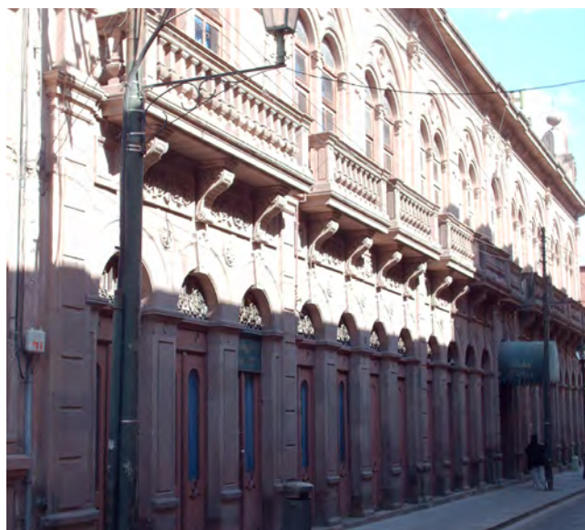
El edificio La Palestina albergó el obispado potosino a mediados de la tercera década del siglo XX, estaba ubicado en la calle de la Fuente. En la actualidad ahí se encuentra el Hotel San Francisco, ubicado sobre la avenida Universidad, entre Zaragoza y 5 de mayo, San Luis Potosí, S. L. P., (fotografía: Jesús Alfaro S.).
