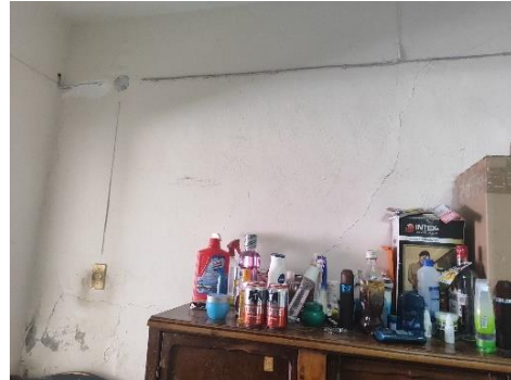
Imagen 13-16. Deterioros presentes en muros de vivienda 2. Fuente: dictamen de unidades de análisis. Imágenes: propias
