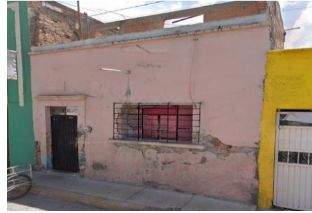
Imagen 1-6. Daños presentes en fachadas de viviendas. Fuente: Centro Histórico SLP. Fotografía: propia
