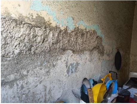
Imagen 13-16. Deterioros presentes en muros de vivienda 2. Fuente: dictamen de unidades de análisis. Imágenes: propias
