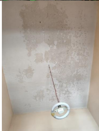
Imagen 37-40. Deterioros presentes en muros y techo de vivienda 8.
