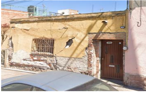
Imagen 1-6. Daños presentes en fachadas de viviendas. Fuente: Centro Histórico SLP. Fotografía: propia
