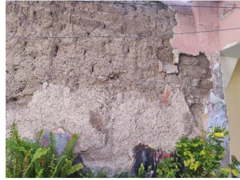
Imagen 33-36. Deterioros presentes en muros, techo y piso de vivienda 7.
