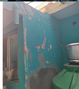
Imagen 17-20. Deterioros presentes en muros de vivienda 3. Fuente: dictamen de unidades de análisis. Imágenes: propias
