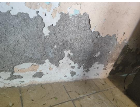
Imagen 17-20. Deterioros presentes en muros de vivienda 3. Fuente: dictamen de unidades de análisis. Imágenes: propias
