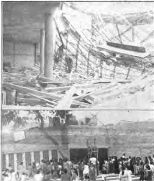
DERRUMBE.— Gran alarido causó entre habitantes de la Unidad Habitacional "Rancho Pavón" al derrumbe del templo de Nuestra Señora de la Encarnación...
