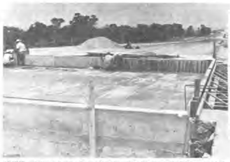
AVANCE.— A ritmo acelerado se llevan a efecto los trabajos de pavimentación de la carretera a la altura del Parque Tangamanga...
