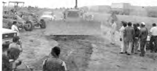
EN MARCHA. — El Gobernador del Estado, licenciado Guillermo Fonseca Alvarez, pone su mano en la obra de ampliación de la Carretera Central 57...
