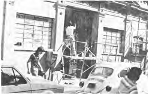
RENTALIZACIÓN.— Varias edificaciones consideradas de alto valor arquitectónico, han sido restauradas en esta ciudad como el que alberga a la administración de Ferromex.
