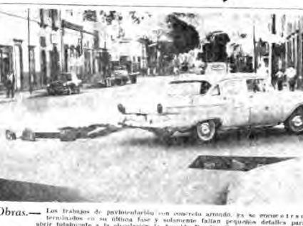
Obras.— Los trabajos de pavimentación con concreto armado ya se encuentran...
