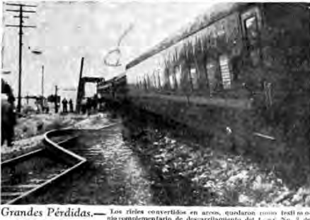
Grandes Pérdidas.— Los rieles convertidos en avíos, quedaron como testigos del cumplimiento de descarrilamiento del tren San Luis de Laredo a México, ocurrido ayer por la mañana a la altura del puente negro, y en el cual quedaron semi volados tres pullman, entre los cuales estaba el Sierra de Oaxaca que aquí puede verse.
