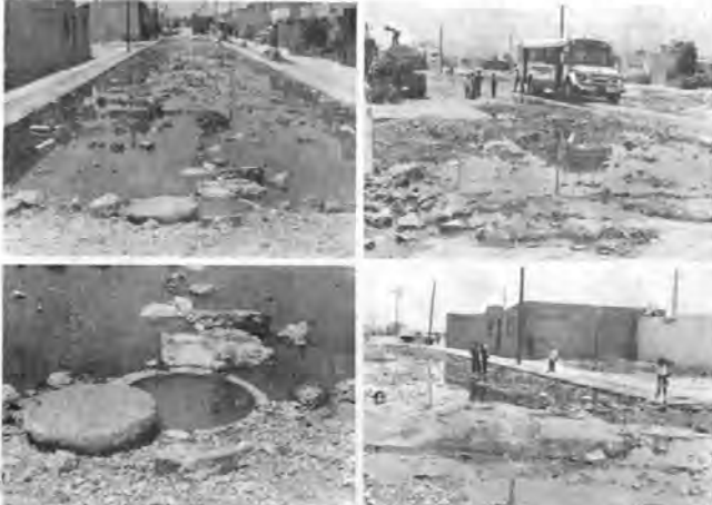
PANORAMA.—Largo de que cuadrillas de trabajadores iniciaron la reparación de los asientos de desape y cimentación en Prados de San Vicente...
