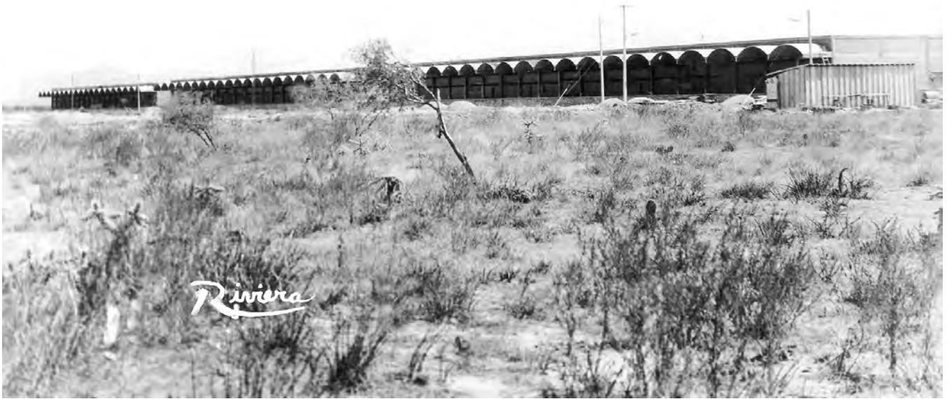
Vista parcial del inicio de la construcción del Centro de Abastos de San Luis Potosí, construido durante el gobierno del Lic. Guillermo Fonseca Álvarez.
