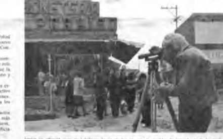
Como se afirmó ayer se iniciaron los trabajos de reorientación de las obras de la esplanada Hidalgo.
