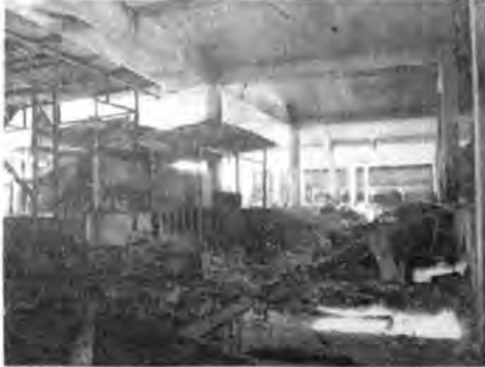
DAROS.— Este era el desolador panorama que presentaban ayer las instalaciones del mercado "República". El Municipio de la capital anunció que procederá a su restauración.
