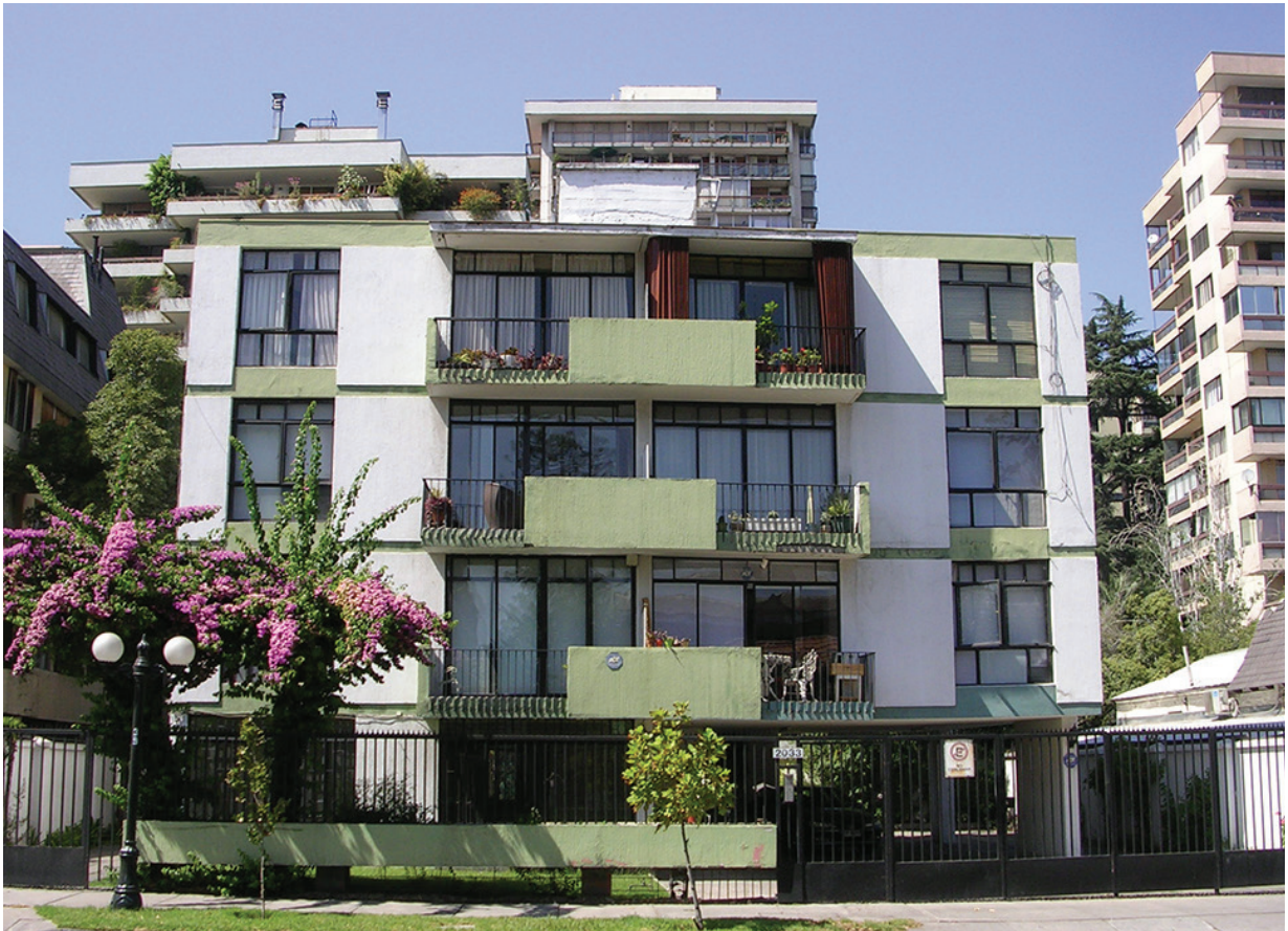
Edificio despacho de Arq. Williams
