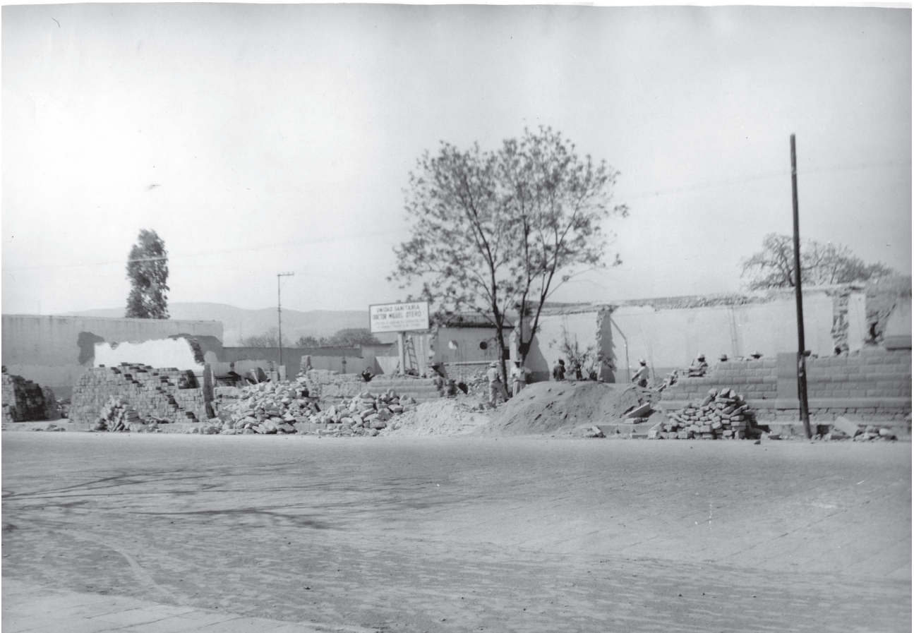
Demolición del Hospital Miguel Otero
