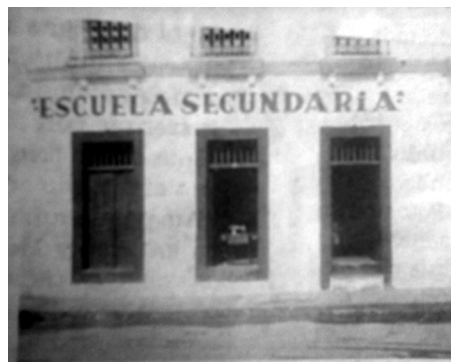
Mientras estaba en construcción la nueva escuela secundaria, por algún tiempo se estableció este plantel en la esquina de la calle Francisco I. Madero y Calle Zaragoza (hoy DIF Municipal).
