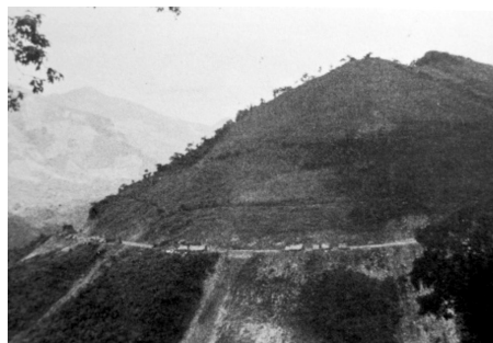
Un trazo muy difícil de la carretera nacional
