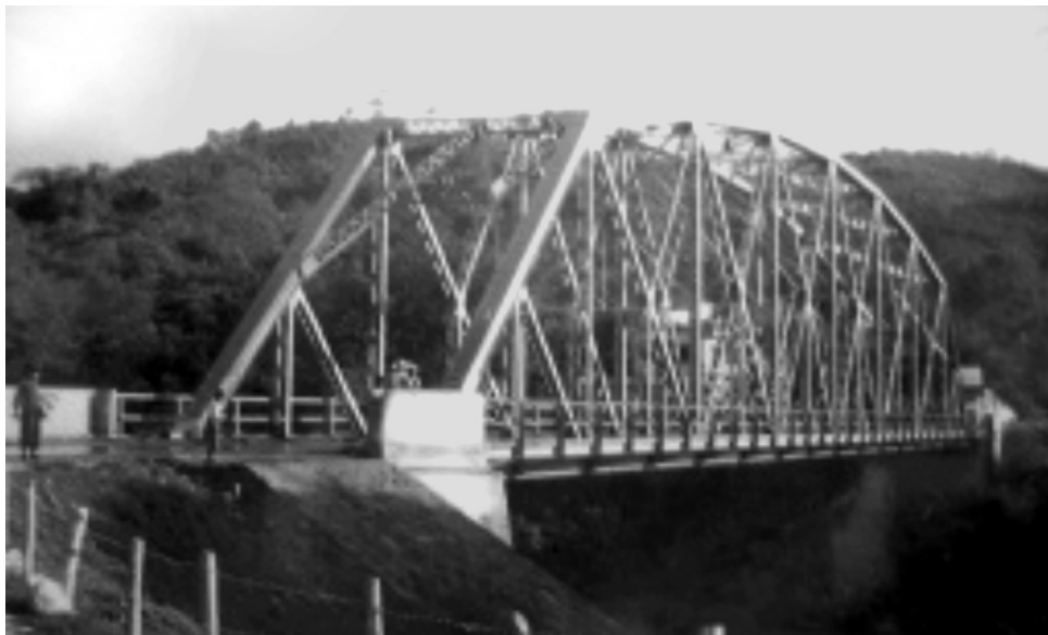
El puente metálico se inauguró el 1 de julio de 1936.
