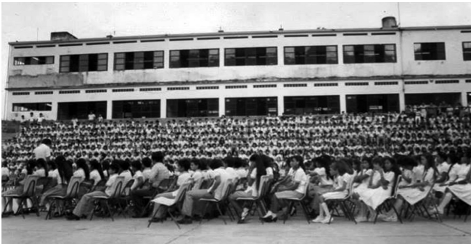
Bella panorámica del edificio y los cimientos, se puede apreciar a los alumnos en el auditorio aún sin techo. Este auditorio se inició cuando eran presidentes de la Sociedad de Padres de Familia Ángel Rodríguez Ballina y Moisés Hervert.
