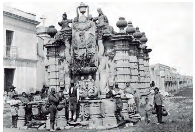
FIGURA 118. ACUEDUCTO DE CHAPULTEPEC (1890)
