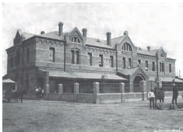
FIGURA 88. ESTACIÓN DE SAN LÁZARO DEL FERROCARRIL INTEROCEÁNICO. 1900
