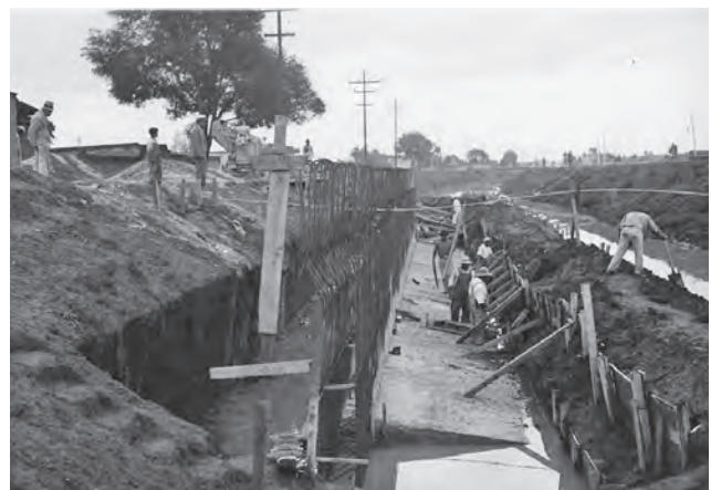
FIGURA 124. ENTUBAMIENTO DEL RÍO CONSULADO, 1936
