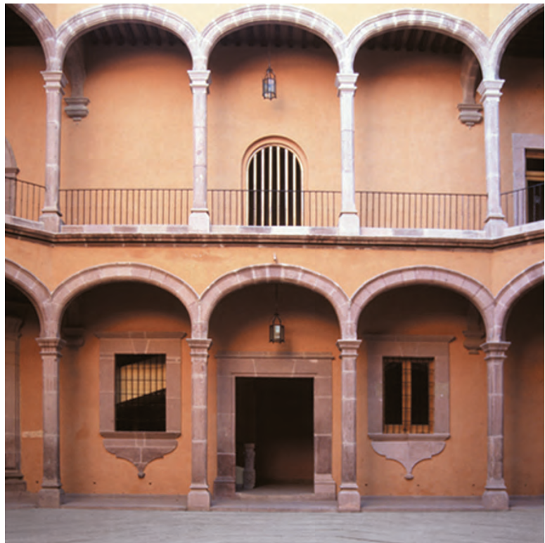
Patio de la Real Caja. Los salones de clase ocupaban la planta baja y alta.
