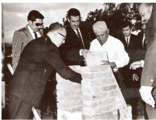
Colocación de la primera piedra de la Escuela de Ingeniería, en el extremo izquierdo el licenciado Antonio Rocha Cordero, Gobernador del Estado, al Centro el licenciado Guillermo Delgado Robles Secretario General de la UASLP y en el extremo derecho el Rector licenciado Guillermo Medina De Los Santos.
