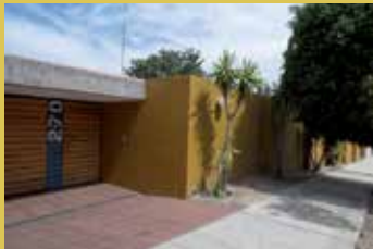
1976. Casa Villalba Paláu Huehuetlán 270 Lomas Primer Sección. (demolida en 2014).
