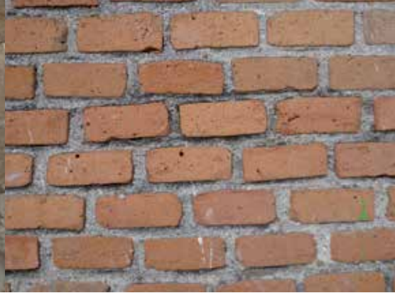
Detalle de muro de ladrillo artesanal, Auditorio Miguel Barragán. Foto: Jesús Villar.
