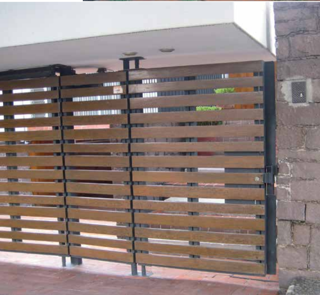
Detalle de puertas y muro de mampostería en fachada. Casa Gómez Valle, Amado Nervo 719, Arq. Francisco Marroquín, 1967. Archivo Marroquín.
