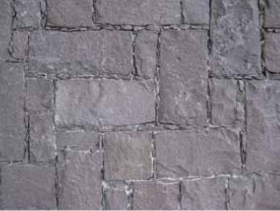
Detalle de muro de sillar de piedra escuadrado, juntado con rajuela, Casa Gómez Valle. Foto: Jesús Villar.
