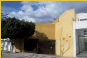
1992-1993. Casa Kaiser Armengol Montes Blancos 342 Lomas Segunda Sec.
