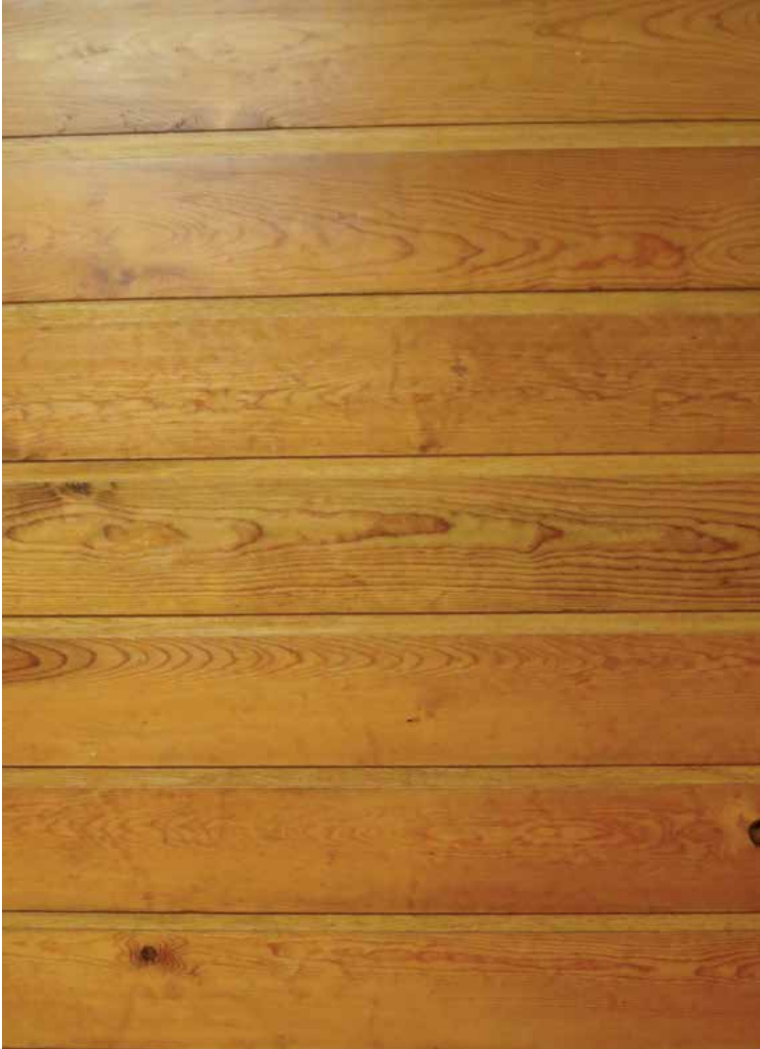
Detalle de lambrín de duela de madera en posición horizontal, Casas gemelas. Foto: Jesús Villar.
