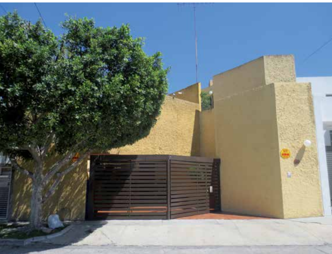
Fachada principal. Casa Kaiser Armengol, Montes Blancos 342, Lomas Segunda Sección. Foto: Jesús Villar.
