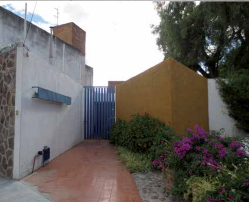
Acceso. Casa Bécena Janet, Miguel de Cervantes 165, Col. Polanco. Foto: Jesús Villar.
