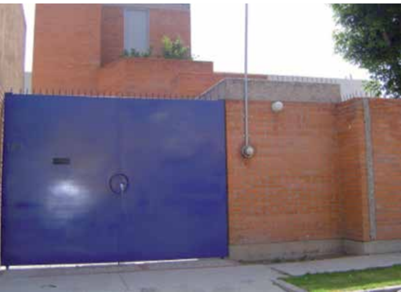
Fachada principal. Casa Abella Zendejas, Gustavo A. Bécquer 180, con la puerta modificada. Foto: Juan Carlos Ramos.
