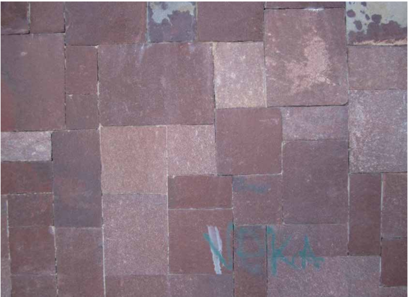
Textura de laja "sangre de pichón", revestimiento del volumen de acceso. Casa Torres Trueba. Foto: Jesús Villar.
