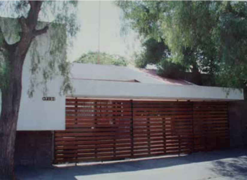
Fachada principal. Casa Gómez Valle, Amado Nervo 719, Arq. Francisco Marroquín, 1967. Archivo Marroquín.
