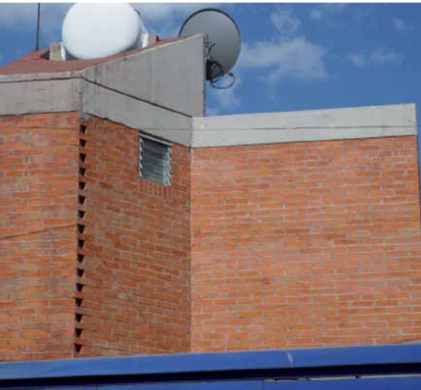
Trabajo del volumen y de materiales aparentes en la casa de la Sra. Marroquín, en Francisco Asís de Castro 135. Foto: Jesús Villar.
