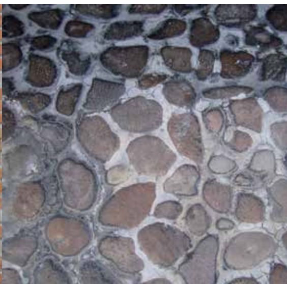
Pavimento de canto rodado, cochera Casa Bárcena Pous. Foto: Jesús Villar.
