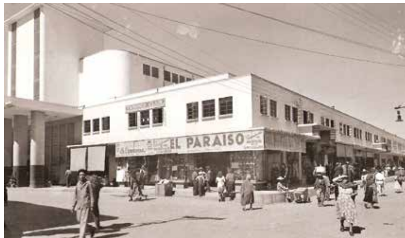
Mercado Hidalgo, Fachadas sur y oriente, 1945, Archivo Ingeniero Valle
