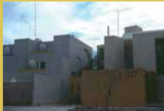
1977. Casa Marroquín Villasuso Tanquián 127 Lomas Primera Sección.
