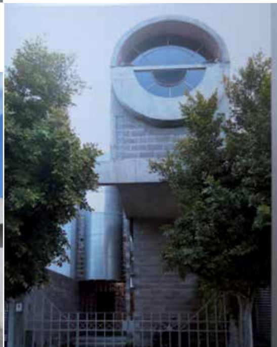
Casa Alfaro Pérez, Arq. José Alfaro, en Arquitectura y urbanismo en San Luis Potosí, San Luis Potosí, Facultad del Hábitat, UASLP, 2002, p. 19.
