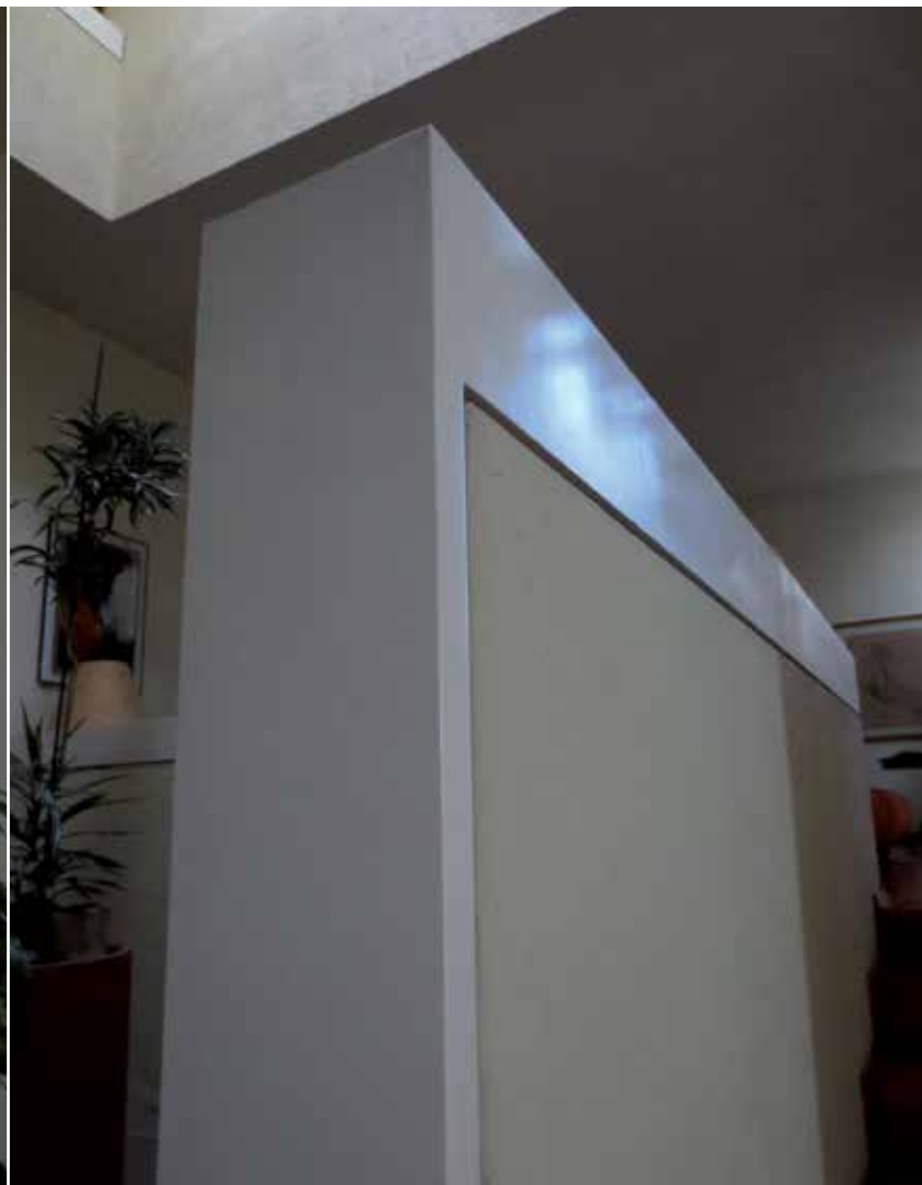
Detalle de remate de muro y barandales en madera y laca blanca. Casa César Saldívar, Francisco de la Maza 125. Foto: Jesús Villar.
