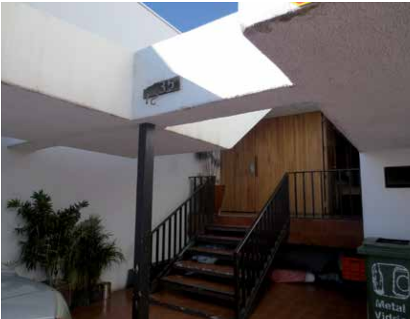
Acceso a la Casa Fonte, volado y cubierta inclinada en la escalera. Foto: Jesús Villar.
