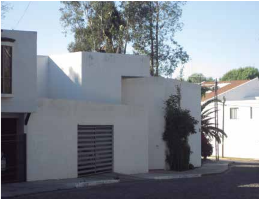
Fachada principal. Casa Abaroa Bárcena, Montes Blancos 470, Lomas Segunda Sección. Foto: Jesús Villar.
