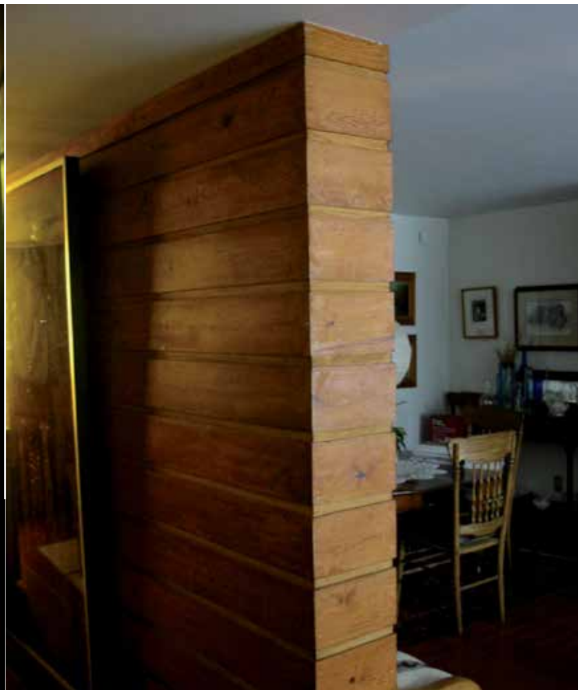
Detalle de recubrimiento de duela de madera de pino. Casas gemelas, Tanquián 125 A, Lomas Primera Sección, Arq. Francisco Marroquín. Foto: Jesús Villar.
