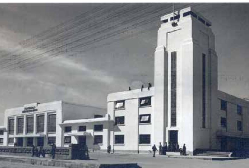
Estación de Ferrocarriles Nacionales (1939-1942). Archivo Histórico del Estado de San Luis Potosí.
