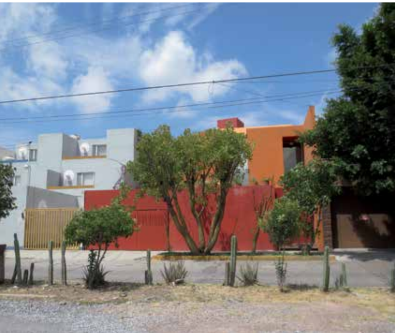
Conjunto de las casas gemelas de la calle Tanquián 125 A y B y de la casa del arquitecto Marroquín, Lomas Primera Sección. Foto: Jesús Villar.
