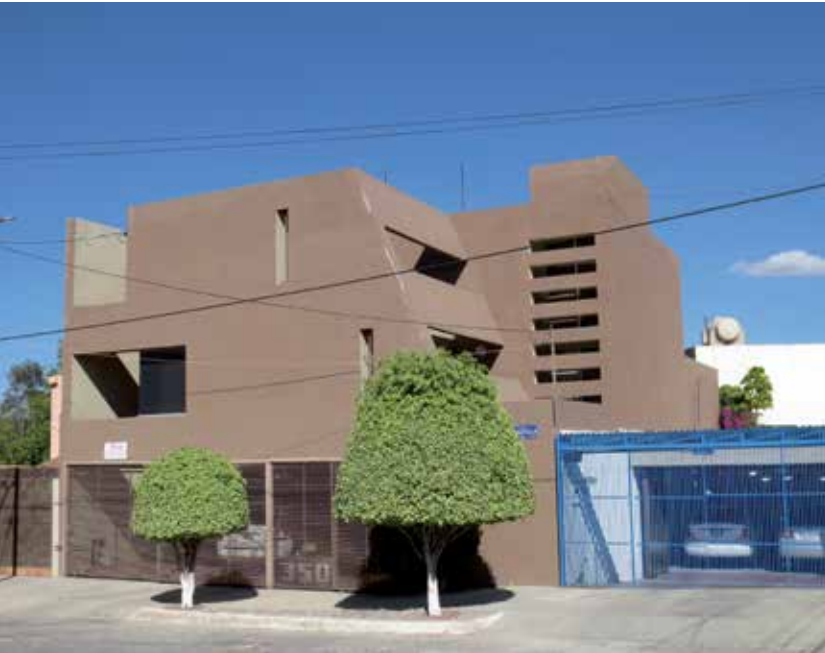
Fachada principal. Casa Hermosillo Villasuso, Huasteca 350, Lomas Primera Sección. Foto: Jesús Villar.
