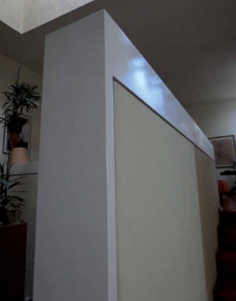
Recubrimiento de madera laqueda en terminación de muretes, barandales y escalera en madera, Casa César Saldívar. Foto: Jesús Villar.
