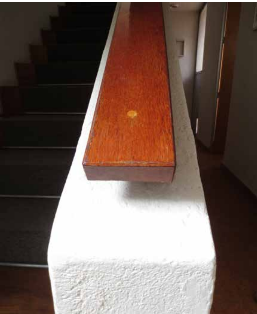
Detalle barandal de madera de cedro y murete. Casa Hermosillo Villasuso, Huasteca 350, Lomas Primera Sección. Foto: Jesús Villar.
