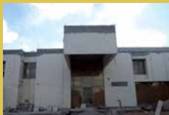
1980. Casa Méndez Rico Picachos 105 Fracc. Loma Alta.
