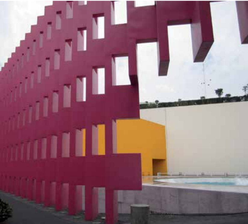
Celosía de acceso al Hotel Camino Real, 1968, Mathias Goeritz. Foto: Jesús Villar.
