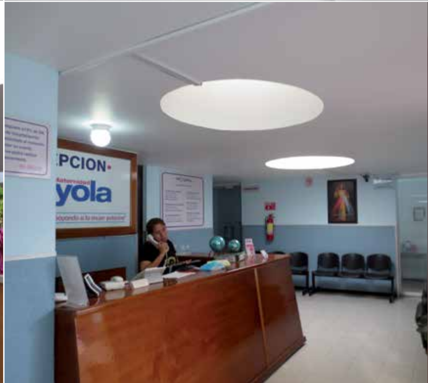
Iluminación cenital en vestíbulo y acceso, Maternidad Jesús Noyola. Foto: Jesús Villar.
