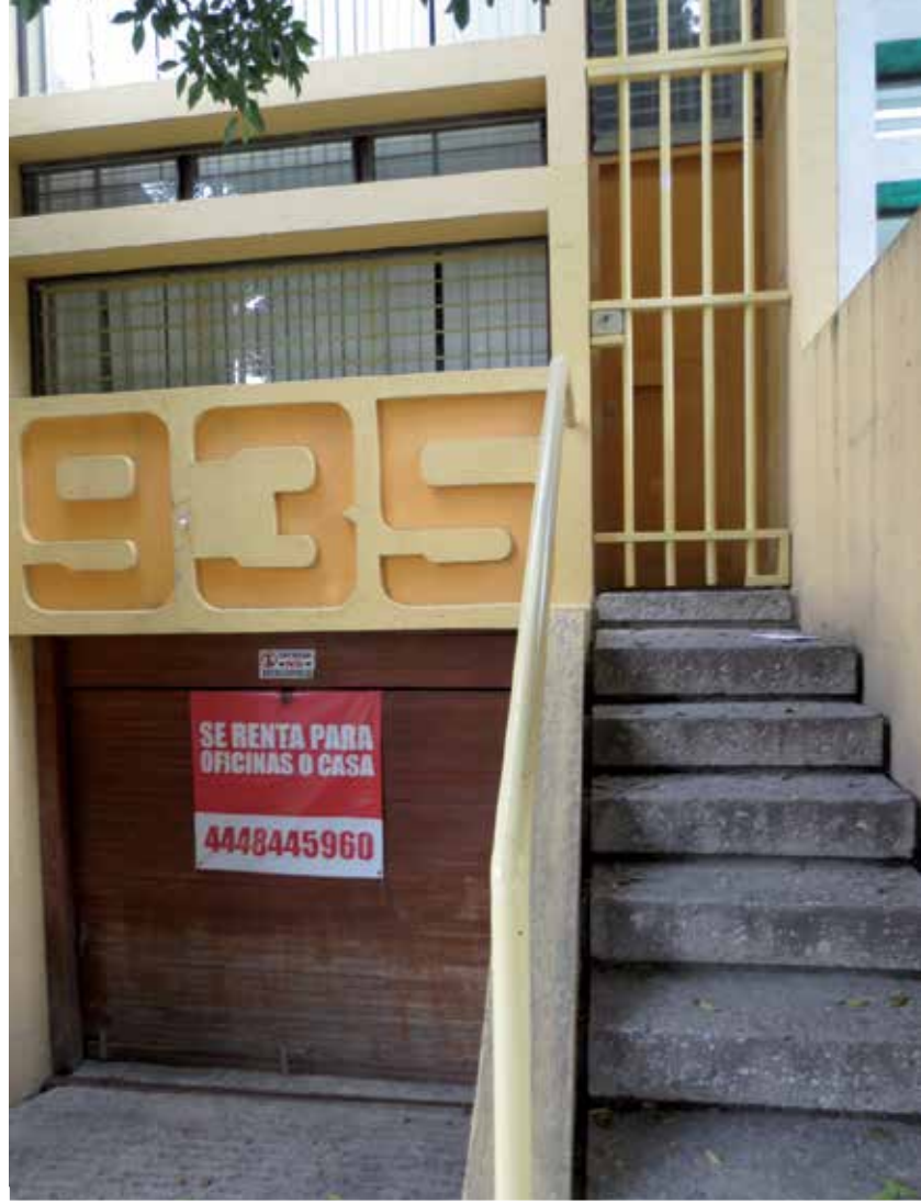
Fachada, casa de Valentín Gama 935, colonia Jardín. Arq. Roberto Villarreal Salinas. Foto: Jesús Villar.
