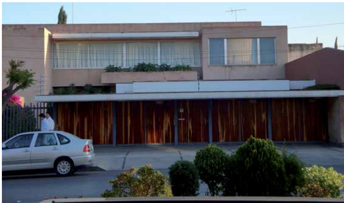
Casa Ortuño Herrera, Cossío y Algara Arquitectos. Foto: Jesús Villar.
