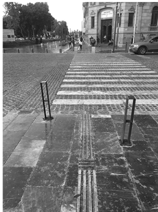
Imagen 3: Ausencia de semáforos peatonales y con sonido. No continuidad de la huella podotáctil para invidentes. Foto: autores, 2019.
