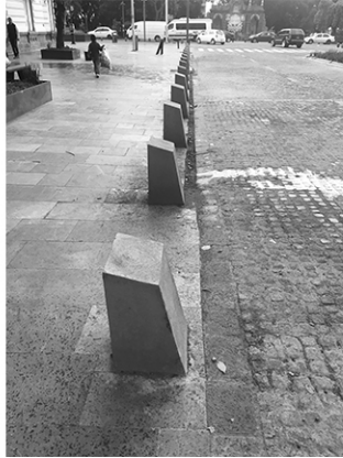
Imagen 2: Nivelación de la acera y calzada sin criterio. Foto: autores, 2019.
