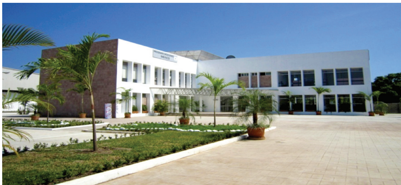
Figura 157. Nuevo Edificio Administrativo del Programa Moscamed México. El Carmen, Cantón Leoncillos, Municipio de Tapachula, Chis.
