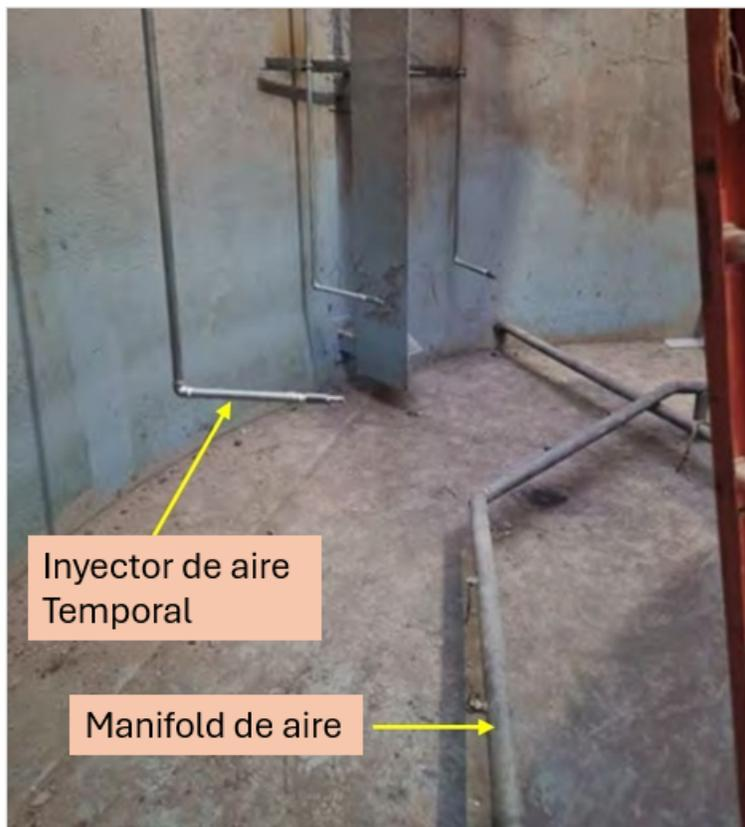
**Figura 2** - Colector de gas existente y configuración temporal de las boquillas SlamJet™ dentro del tanque de lixiviación
