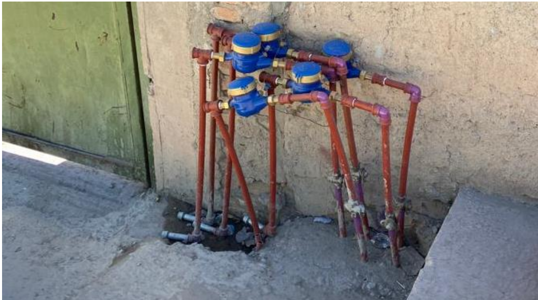
Figura 20. Fotografía de instalaciones de nuevas tomas domiciliadas de Agua en Escalerillas S.L.P. Fuente: Captura personal en una visita a la región, 2024.
