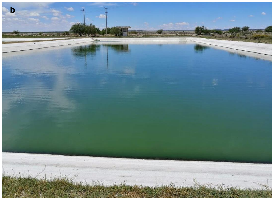
Figura 7. Planta de tratamiento de agua en Salinas, S. L. P. a) Esquema general del funcionamiento de la planta tratadora, b) Aspecto de la planta tratadora.
