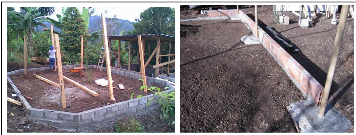
Figura 4. Contorno de concreto y block.
