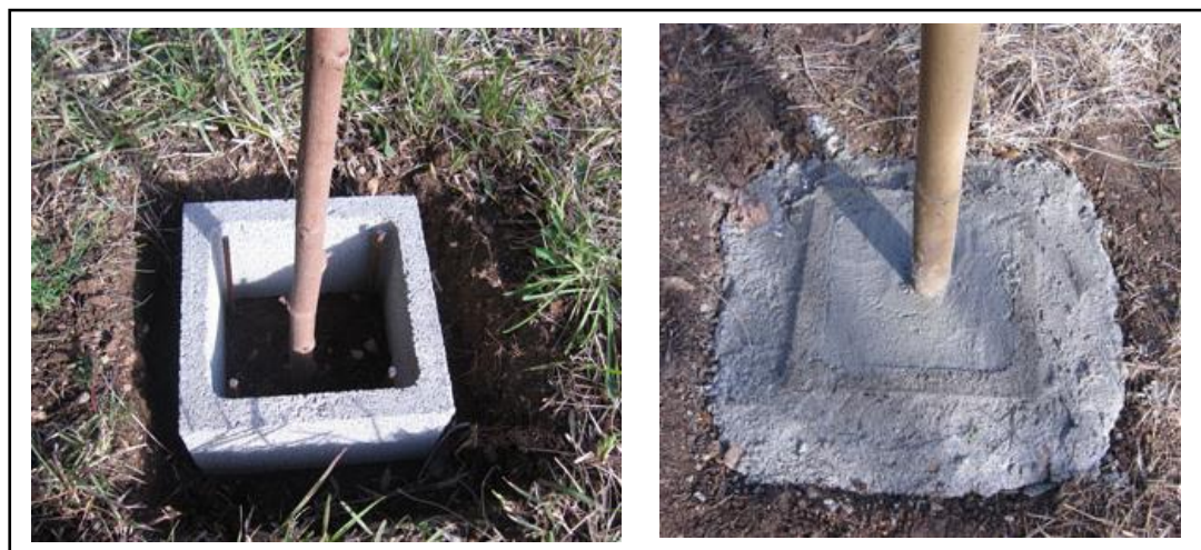
Figura 5. Afianzado de esquinas y relleno de tubos de PVC.
