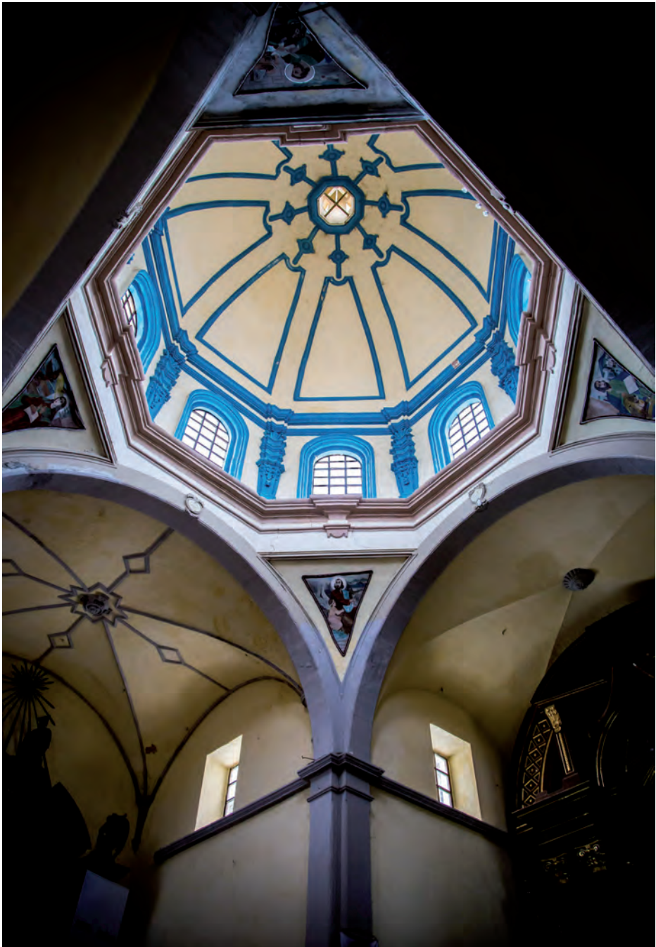
Interior de la cúpula de la Parroquia de la Inmaculada Concepción.
