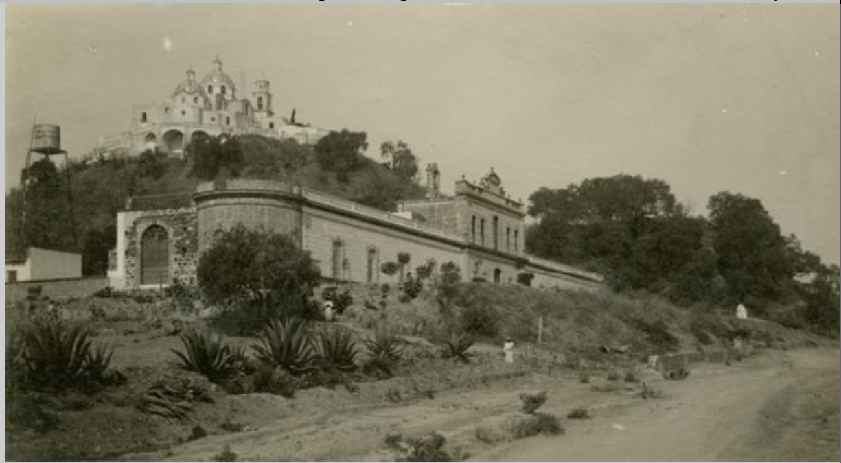
Vista Panorámica del Ex Hospital Psiquiátrico, s/a. Colección de John O'Leary.
