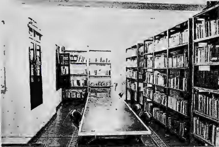
Biblioteca de la Casa de San Sebastián Fotografía tomada por las tesisistas con permiso de la biblioteca
