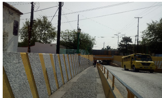
Figura 38: Puente de Ferrocarril por el cual fue demolida una de las fachadas del templo de Montecillo. Fotografía propia.
