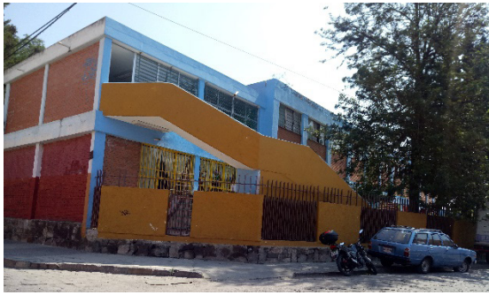
Figuras 30: Estado Actual de la Escuela Manuel José Othón. Fotografías propias.
