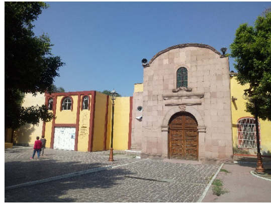
Figura 35: Fachada actual del templo de Montecillo, el templo fue reducido debido a la llegada del ferrocarril. Fotografía Propia.
