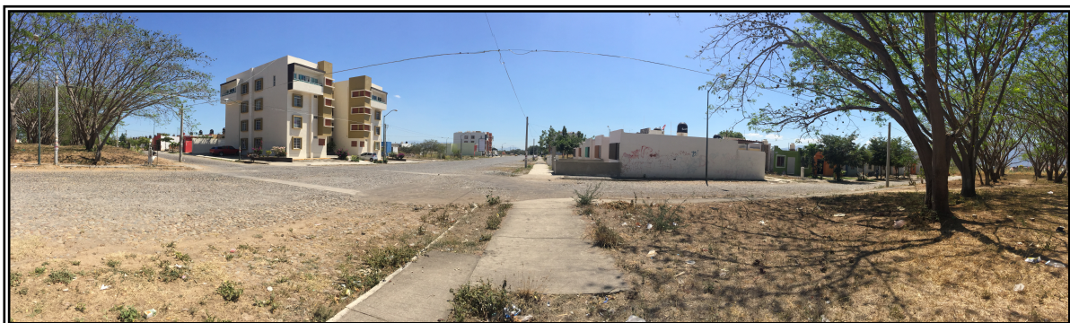
Fotografía No. 4. Diversas tipologías arquitectónicas. Fraccionamiento Buenavista. Vista panorámica.
