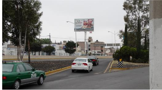
**Figura 70.** La aplicación de los bordes son identificados como la separación de los tipos de vía, ya sea vía rápida o vía lateral teniendo en varias distancias conexiones para la integración de dichas vías (arriba).
