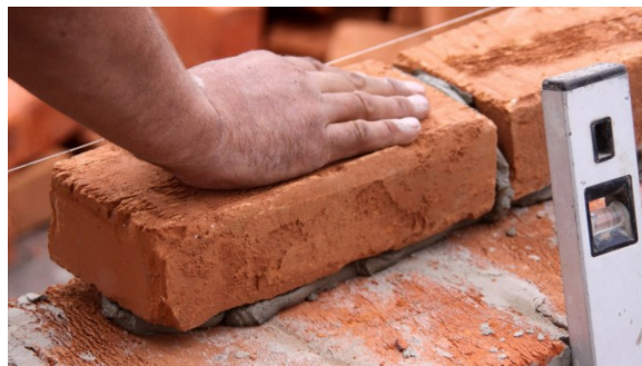
Figura 31: Muros de ladrillo.
