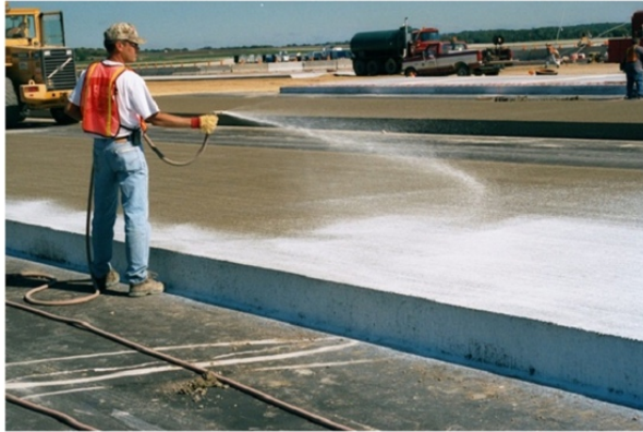
Figura 32: Curado de un firme de concreto.
