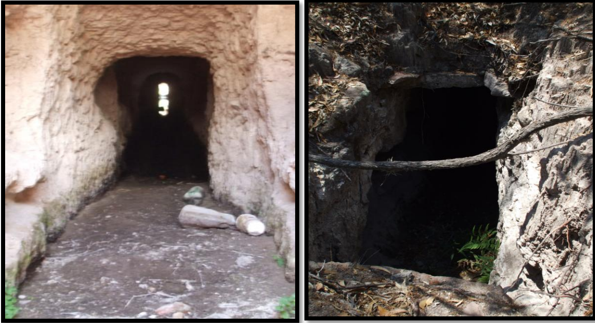
Ilustración 5 Interior y exterior de una de las lumbreras de la Cañada del Lobo, Cañada del Lobo, julio 2012.
