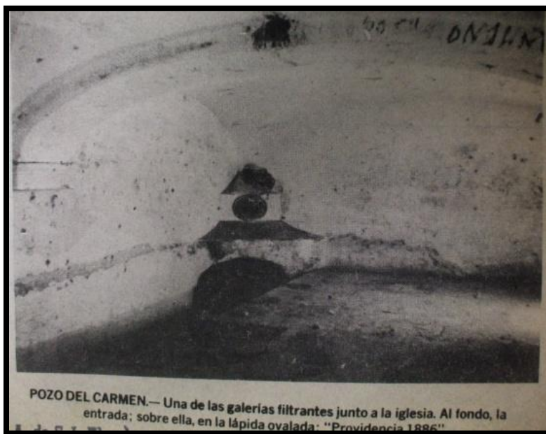
Ilustración 2. Pozo del Carmen, vista de una de las galerías filtrantes existentes junto a la iglesia, en: Montejano “Acueducto”
