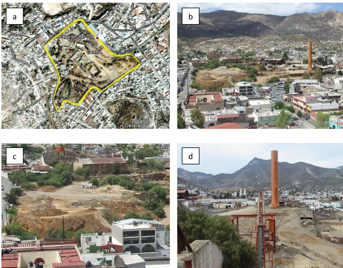
Figura 5.37 Antigua área de fundición en la ciudad de Concepción del Oro: a) Fotografía aérea del área de fundición en el centro de la ciudad; b) vista de las instalaciones; c) acercamiento a lo que parecen ser residuos de trituración o terreros; y d) banda de quebradoras en el interior de las instalaciones.
