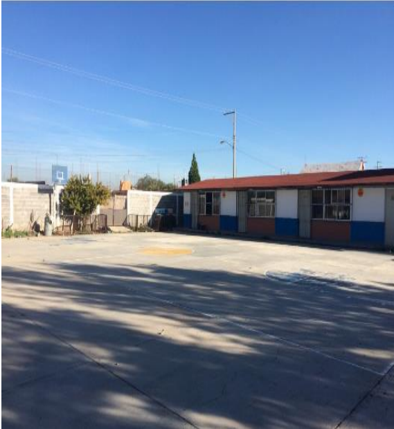
Figura 28. Escuela Francisco González Bocanegra antes de la intervención
