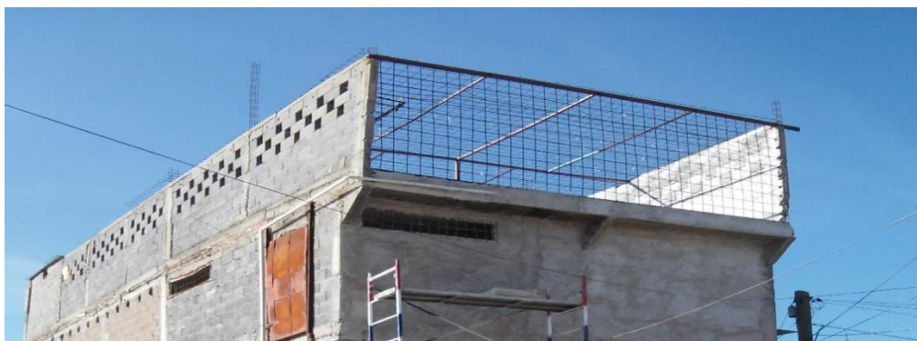
Fig. 1 Vista de la fachada del CR, en particular pisos 3 y4.
