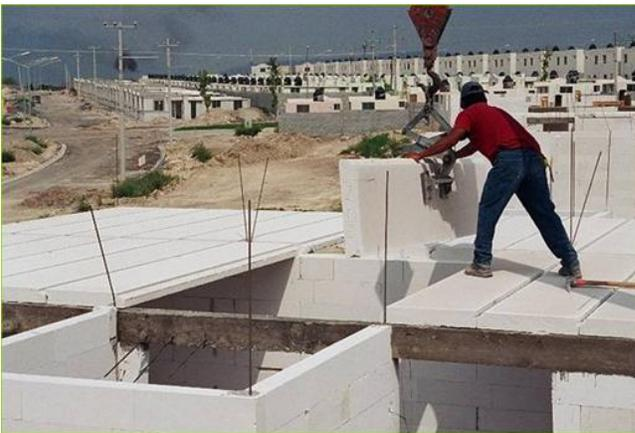
Imagen 18: Colocación de panel Hebel
