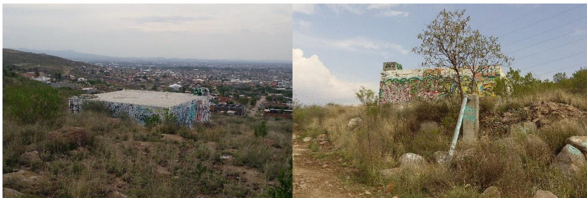
Figura. 28. Cisterna de concreto a través de la cual se distribuye el agua para consumo personal y doméstico en la Localidad La Virgen dentro de la Comunidad San Juan de Guadalupe, acervo personal, 15 de abril de 2016.
