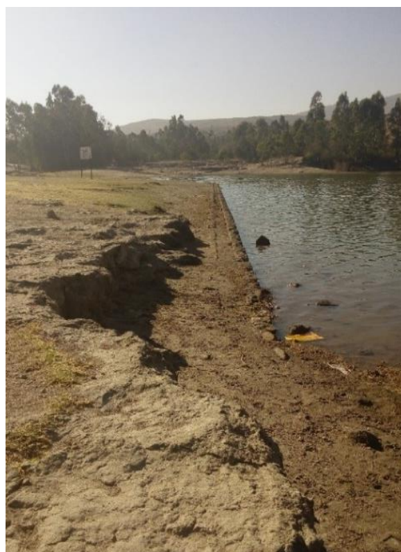
Figura. 23. Acueducto del antiguo sistema de abastecimiento de agua de la Ciudad de San Luis Potosí “Cañada de Lobo”, acervo personal, 07 de marzo de 2016.
