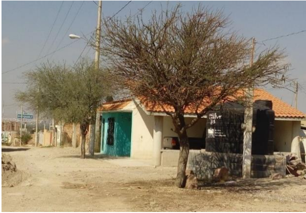
Figura. 30. Tinaco de agua que sirve para abastecer a 2 familias en la localidad de Tierra Blanca dentro de los límites de la Comunidad San Juan de Guadalupe, acervo personal, 15 de abril de 2016.
