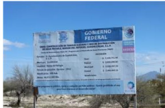
Imagen 76. Obras en Norias del Refugio, Guadalcázar (Tejeda, 2014).
