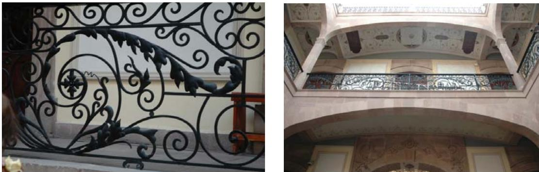
**Fig. 3.177** Imagen izquierda, detalle de herrería con diseño fitomorfo y trazos sinuosos en fierro laminado; derecha, tramo largo de fierro forjado, laminado y vaciado. Fotografías: LDG. Ricardo A. Martínez Galla.
