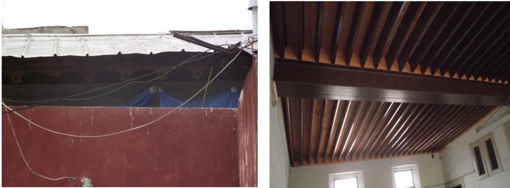
**Fig. 2.65** Imágenes: izquierda, cubierta de lámina del ático; derecha: estructura interior del techo del cubo de la escalera principal en el segundo piso (tramo arquitectónico poniente), a base de vigas de madera. Fotografías: Guadalupe Castillo Duque.
