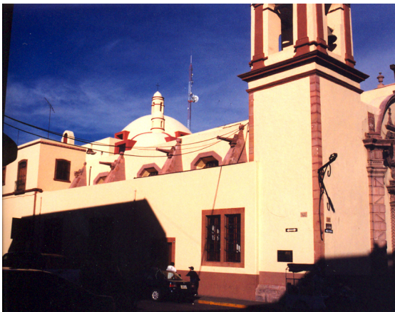
22. Vista lateral de la capilla de Loreto, nótese la presencia de los salones contiguos que afectan la volumetría visual de los originales contrafuertes. Fotografía. JAHS
