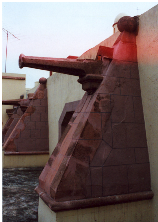
23. Vista de los remates de los cuatro contrafuertes que aun quedan en Loreto. Fotografía. JAHS
