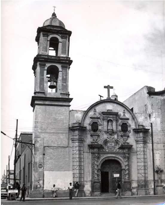
4. Portada de la capilla de Loreto y torre del Ex-conjunto jesuita de la ciudad de San Luis Potosí. 1960 aproximadamente. Archivo fotográfico del Seminario Mayor de San Luis Potosí.
