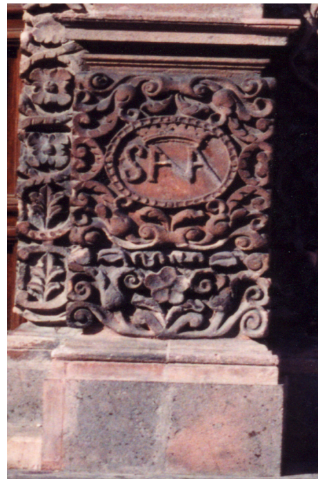
14. Zócalo y dado de las columnas. Es de resaltar el labrado y las cartelas flamencas. Fotografía: JAHS.
