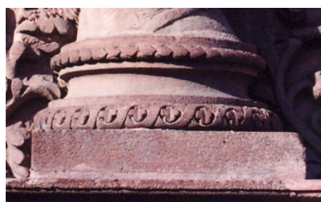
45 y 46. Decoración del toro de la basa propuesto por Serlio en la lámina LVI del Tercer libro y su similitud con la solución de la basa de la capilla de Loreto. Imagen: Grabado Lámina LVI Tercer libro, UAEM, 1978. Fotografía JAHS.
