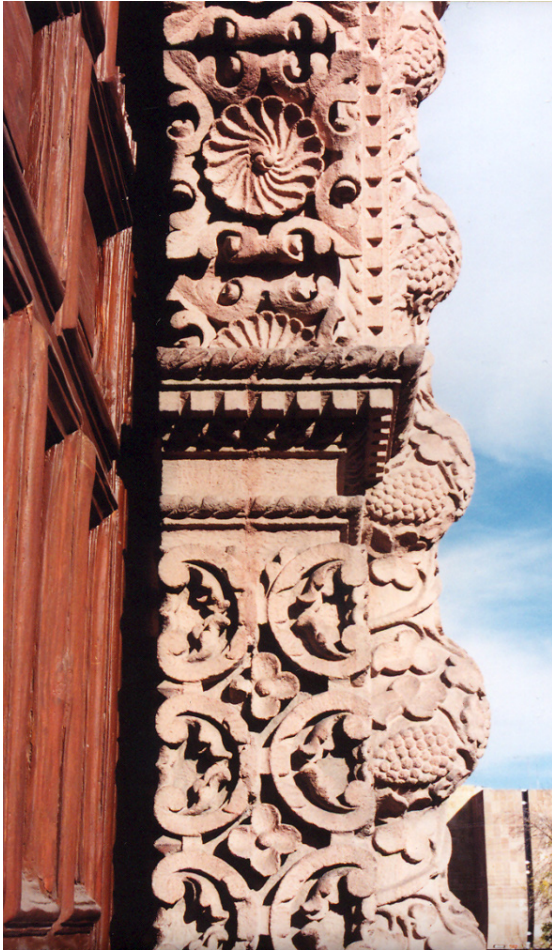
13. Detalle de las jambas y el intradós del arco de acceso a la capilla de Loreto. Nótese el pronunciamiento de los senos y gargantas de las columnas salomónicas. Foto: JAHS.
