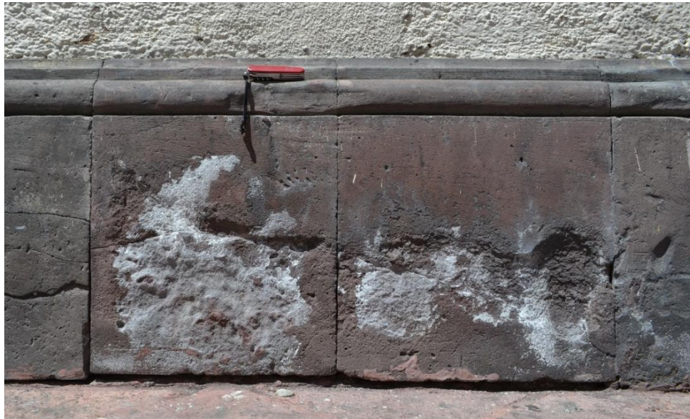
Figura 37. Ejemplo de deterioro de la roca debido a la agresiva acción de eflorescencia salina en el Centro histórico de Santiago de Querétaro
