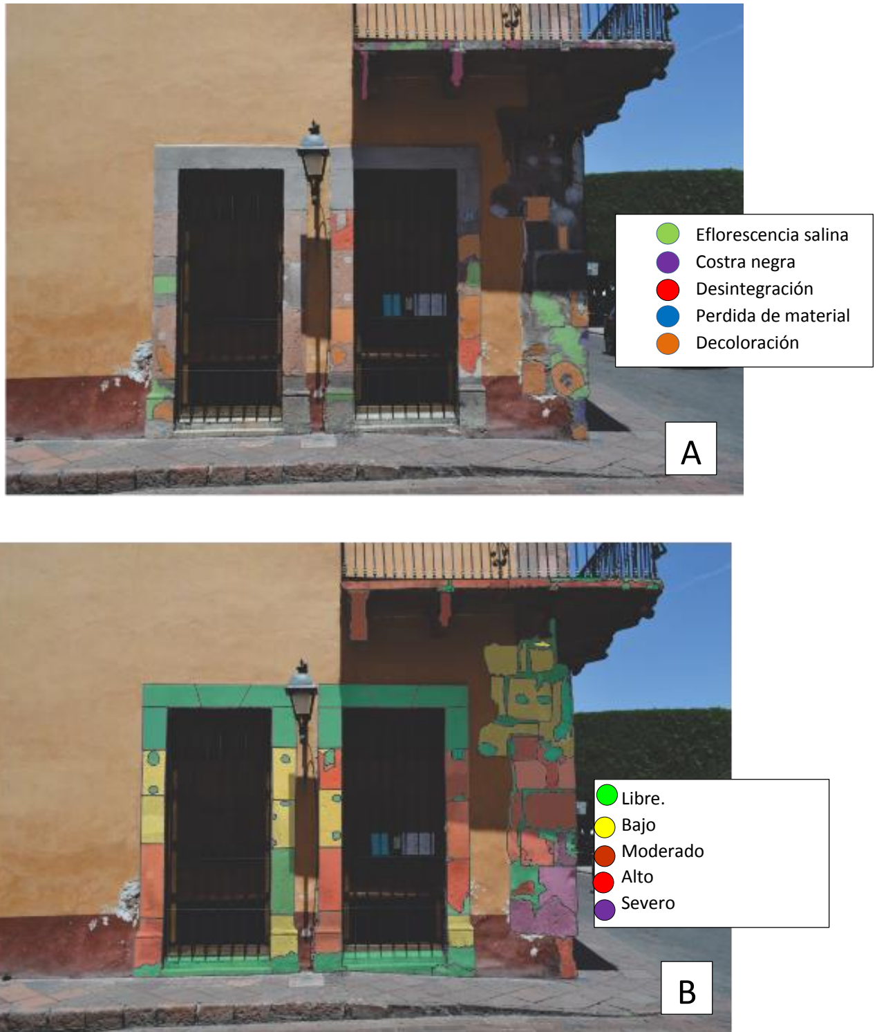
Figura 117. Casona Centro Histórico de Santiago de Querétaro A) Mapeo formas de intemperismo. B) Mapeo intensidad de daños
