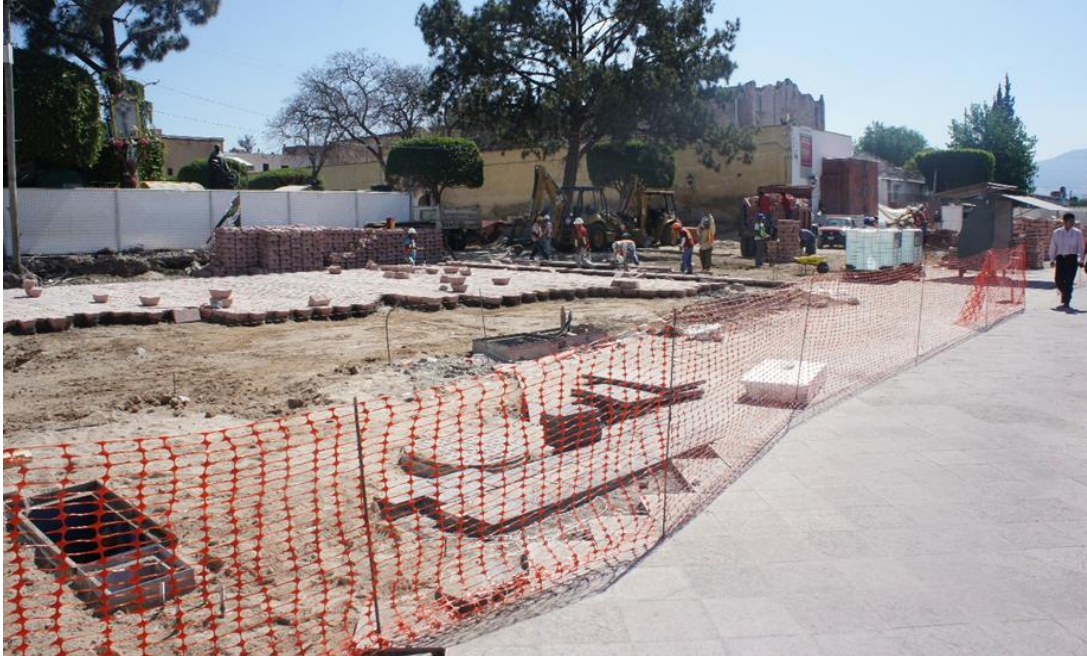
Figura 100. Obras de remodelación en la Plaza fundadores de Santiago de Querétaro. Se puede observar la colocación del adoquín elaborado con la Ignimbrita Rosa de la Cañada (TRCQ1).
