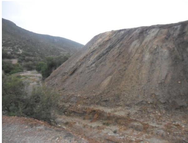
Figura 5. Depósito de residuos en Cerro de San Pedro llamados “Patio Victoria”
