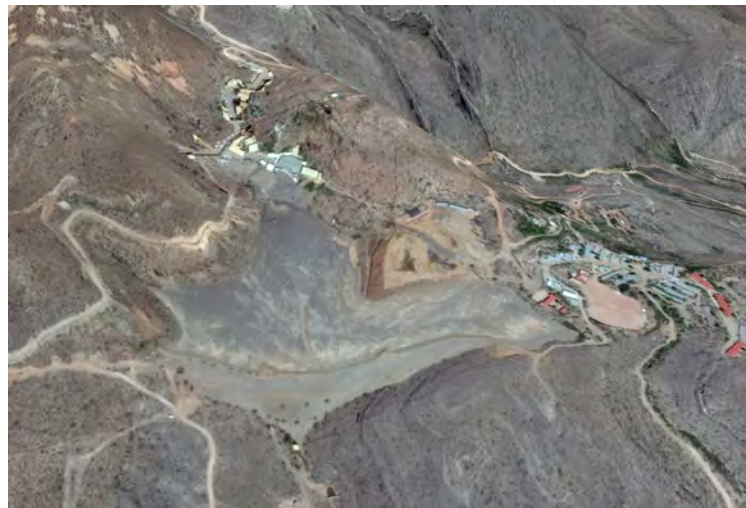
Figura 6.39.: Instalaciones y presa de jales de la mina San Antonio (al centro y a la izquierda), pueblo de San Antonio (derecha).
