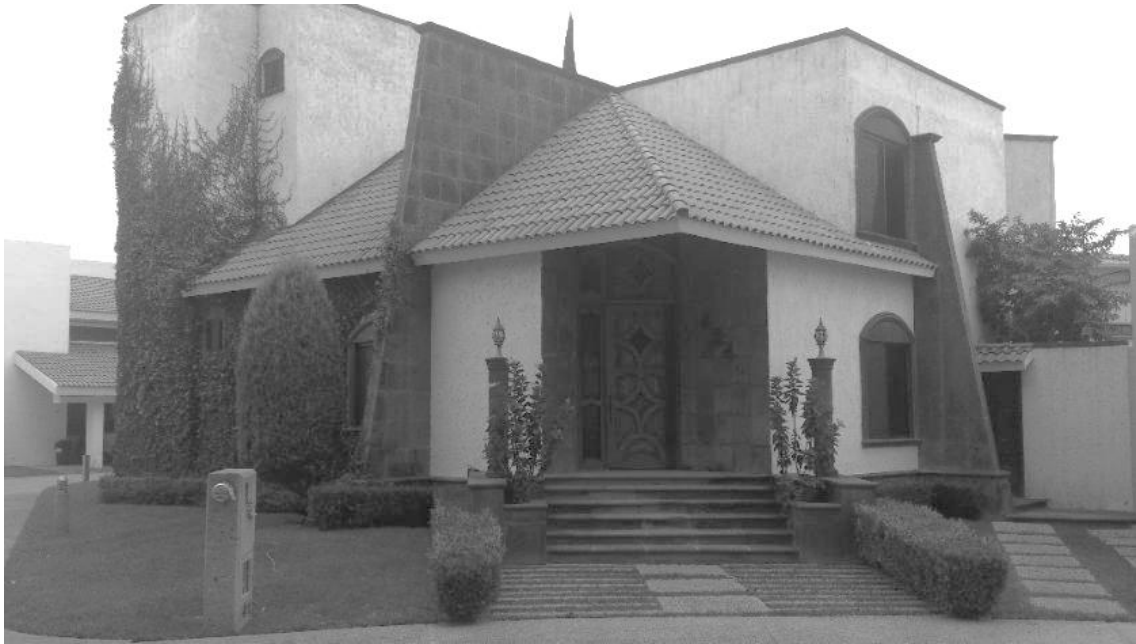
Figura 24. Ejemplo de tipología de la vivienda en Villantigua
