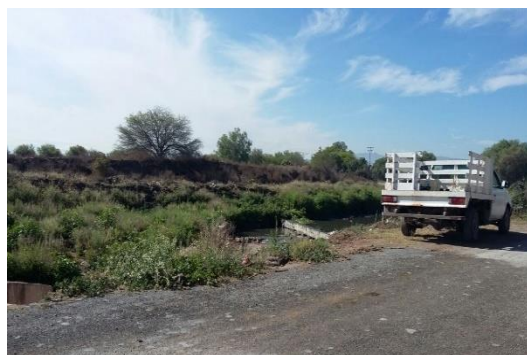
Fig. 61. Canal de aguas negras.
