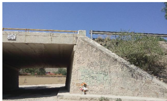
Fig. 17. Puente peatonal para cruzar el periférico.
