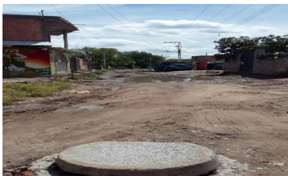
Fig. 60. Calle sin pavimentar y con agua del drenaje.
