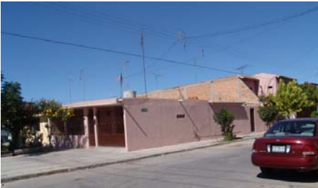
Foto1: Retornos, vista de una casa en esquina, se puede apreciar tamaño de vivienda
