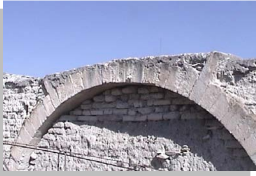
Imagen No. 4.51 Vista de arco de descarga formado por piezas estándar de piedra caliza.
