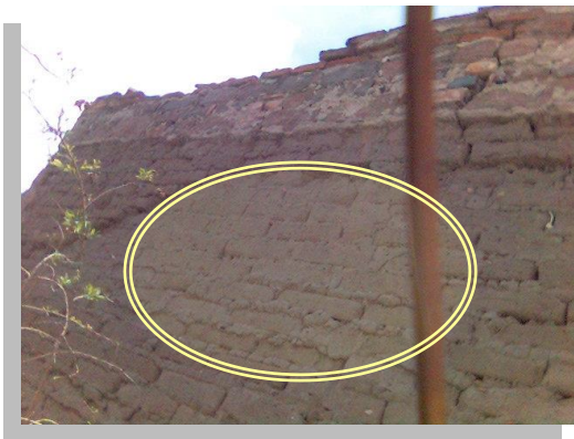
Imagen No. 5 Aparejo común de un muro de vivienda del Barrio de San Miguelito donde se aprecia la misma técnica constructiva de los de la Hacienda del Refugio conservando vestigios del rajueledo original.
