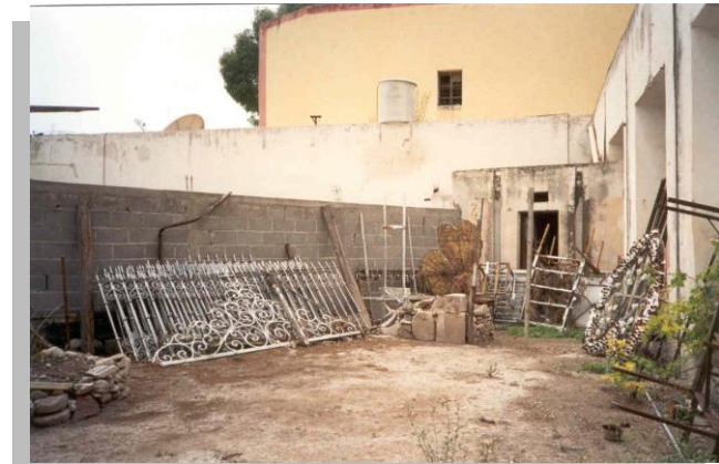
Imagen No. 3.15 Vista del patio principal al interior del ex convento franciscano. Nótese la barda de block de concreto que divide diagonalmente este espacio histórico.
