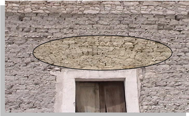
Imagen No. 4.49 Vista de arco de descarga de puerta crujía norte formado por piezas estándar de adobe.
