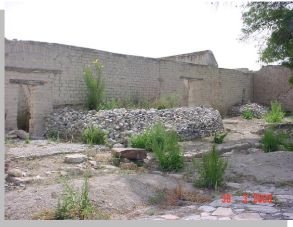
Imagen No 4.12 Vista de las crujías sur pertenecientes a la zona de servicio de la ex Hacienda del Refugio
