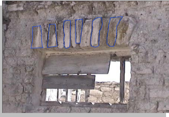
Imagen No. 4.56 Vista de arco de adobe rematado con una clave de piedra caliza
