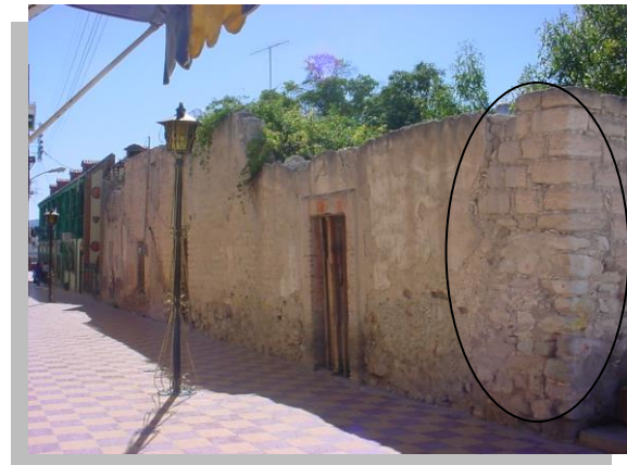
Imagen No. 3.19 Vista de una casa popular del poblado de Charcas en donde se aprecian las características de su sistema constructivo. Nótese la utilización de piedra en los refuerzos de esquina.
