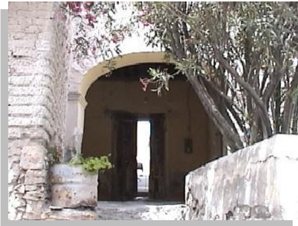
Imagen No. 4.35 Vista de las pilastras que sustentan el arco escarzano de la entrada principal, así como de la base de la arco de medio punto que articula los dos patios de la Hacienda del Refugio.
