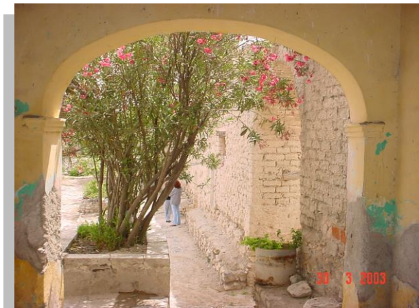
Imagen No 4.15 Vista del arco de tres puntos que da acceso al patio principal y zaguán de la ex Hacienda del Refugio
