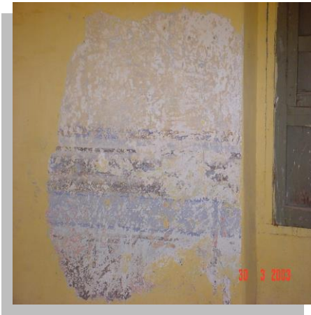
Imagen No. 4.76 Vista interior de la crujía norte donde puede apreciarse los restos de la pintura mural encontrada. Obsérvese que lamentablemente los trabajos de rescate no fueron iniciados con las técnicas de restauración indispensables
