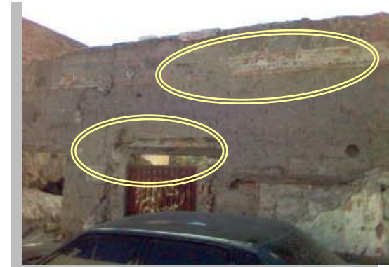
Imagen No. 6 Sistema de dintel de madera en vano de puerta en una vivienda del Barrio de San Miguelito. Obsérvese los enrasos de muro con la bóveda de azotea, en este caso de ladrillo de barro.
