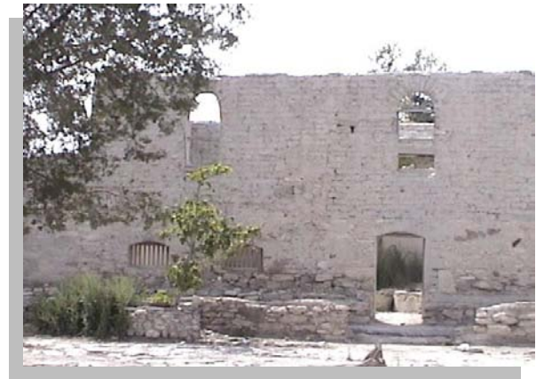
Imagen No. 4.32 Vista de muro de 90 cm. perteneciente a la crujía oriente observada desde el patio principal
