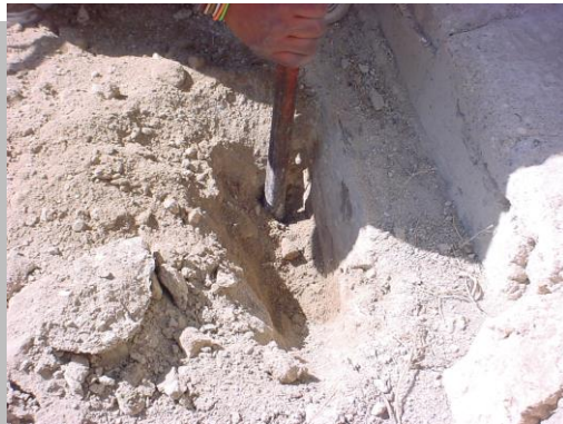
Imagen No. 4.82 Vista de los trabajos de sondeo realizados en busca de piso en la crujía sur
