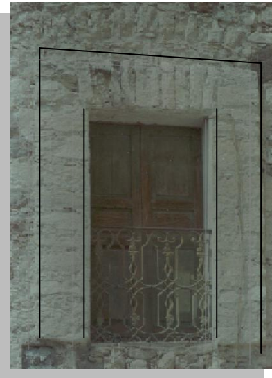
Imagen No. 3.14 Portada de ventana en el templo de Jesús en donde se aprecia el enmarcado de piedra caliza
