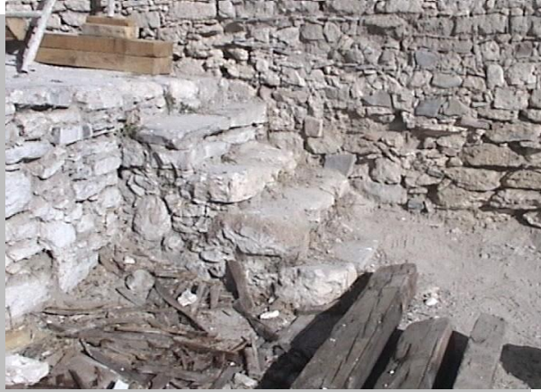
Imagen No. 4.72 Vista de escalones de piedra que conectan el andador de la crujía norte y el patio principal
