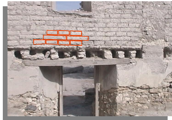
Imagen No. 4.30 Vista de estudio de modulación del muro de 90 cm. perteneciente a las crujías oriente del patio principal
