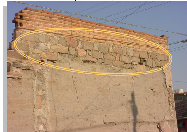
Imagen No. 10 Vista de pretil de piedra similar al utilizado en la Hacienda del Refugio en una vivienda del barrio de San Sebastián. Nótese la ampliación hecha con tabique
