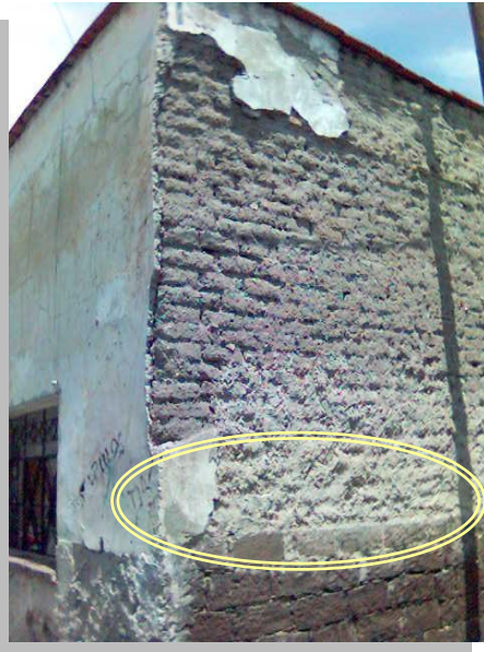
Imagen No. 7 Vista de la prolongación de la piedra utilizada en la cimentación a manera de rodapié similar al sistema de la Hacienda del Refugio.
