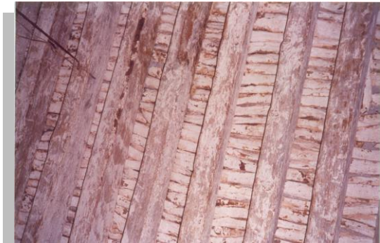
Imagen No. 4.68 Vista de la techumbre de viguería y tejamanil de la crujía norte, nótese la diferente colocación del tejamanil en sentido perpendicular a la viguería.
