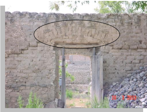
Imagen No. 4.46 Vista del dintel de madera de una puerta en la crujía sur. Nótese el arco de refuerzo sobre el dintel de madera
