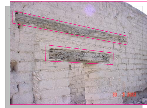
Imagen No. 4.47 Vista de un par de dinteles de madera en donde se puede apreciar la existencia de un vano mayor.
