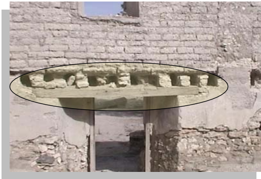
Imagen No. 4.44 Vista del dintel de madera de una puerta en la crujía poniente.
