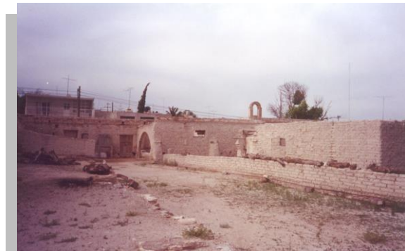
Imagen No 4.8 Vista donde se aprecia un ángulo del segundo patio lateral de la zona de trabajo de la ex Hacienda del Refugio
