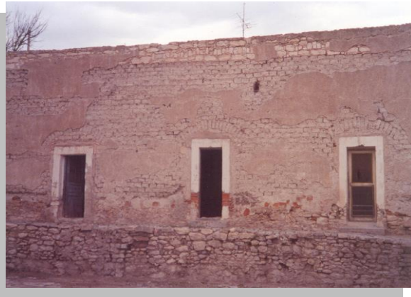
Imagen No 4.9 Vista de las crujiás norte posiblemente utilizadas para fines administrativos de la ex Hacienda del Refugio
