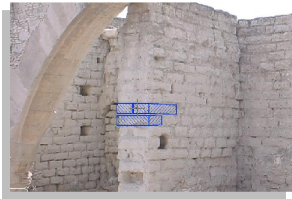
Imagen No. 4.29 Vista de estudio de modulación de uno de los muros de 60 cm de las crujías de servicio
