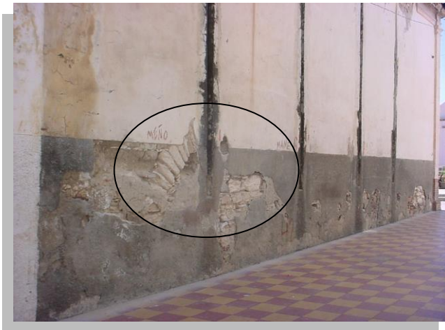
Imagen No. 3.20 Detalle de un arco de descarga formado por piedra caliza en una edificación del siglo XIX en el centro histórico del poblado de Charcas.
