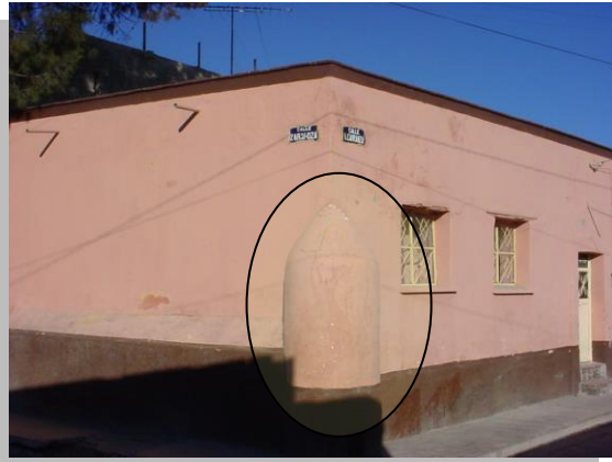
Imagen No. 3.18 Vista de contrafuerte en una casa habitación del poblado de Charcas. Obsérvese su característica formal lo cual hace pensar por su ubicación que funciona como guardacantón
