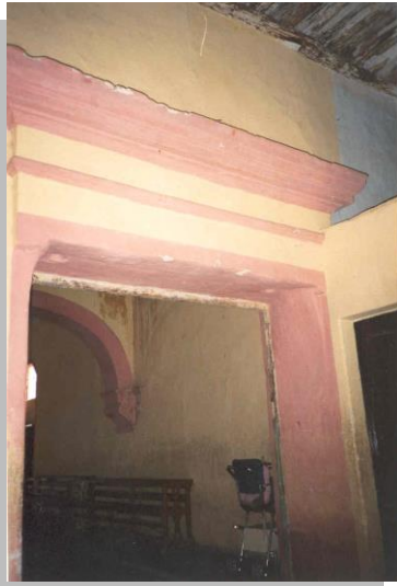
Imagen No. 3.16 Vista del Portal de Peregrinos del ex convento franciscano. Nótese la rusticidad de la técnica de construcción de los remates de la misma.
