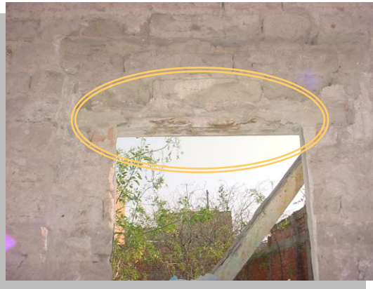
Imagen No. 11 Vista de cerramiento de madera en vano de puerta similar al utilizado en la Hacienda del Refugio en una vivienda del barrio de San Sebastián.
