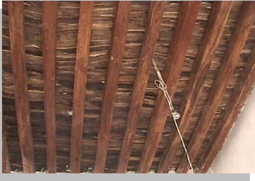
Imagen No. 4.63 Vista de techumbre fabricada a base de vigas y tejamanil de madera en las crujías norte de la Hacienda del Refugio
