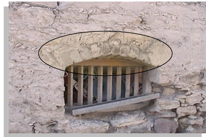
Imagen No. 4.50 Vista de arco de cerramiento de ventana crujía poniente formado por piezas estándar de adobe.
