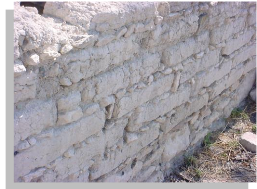
Imagen No. 4.27 Vista de paramento de un muro de la Hacienda del Refugio, donde se puede observar restos del rajueleado
