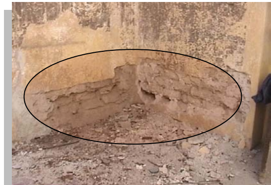
Imagen No. 4.75 Vista interior de muro de la crujía norte nótese el aplanado de cal terminado con pintura a la cal que lucio durante su ultima etapa de vida útil.
