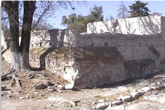
Imagen No. 4.42 Vista de de los contrafuertes corridos en los muros de la pila principal
