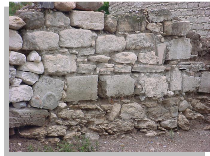
Imagen No. 3.22 Vista de los sistemas de construcción de un muro en el poblado de Charcas donde se aprecia el aparejo del muro sobre cimentación de piedra caliza y lajas de tepetate.
