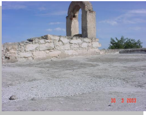
Imagen No. 4.84 Vista del arco tipo espadaña para sostener la campana de la hacienda.
