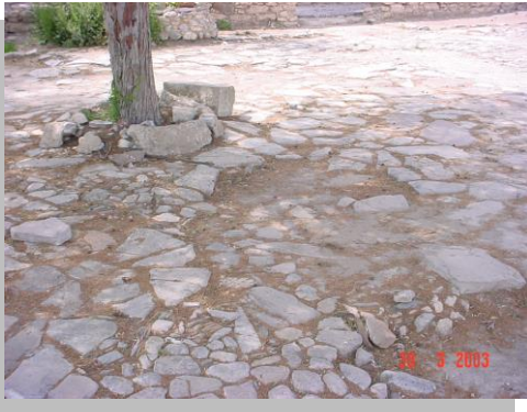
Imagen No. 4.80 Vista del empedrado del patio principal, donde destacan las baldosas de piedra colocada en aparejo casuístico.
