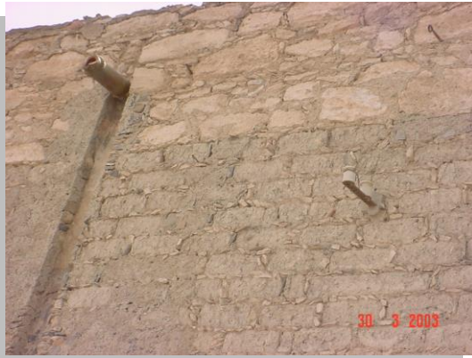
Imagen No. 4.74 Vista del paramento de muro de la crujía norte donde se aprecia el rajueleado utilizado en las boquillas del adobe para recibir el aplanado de cal
