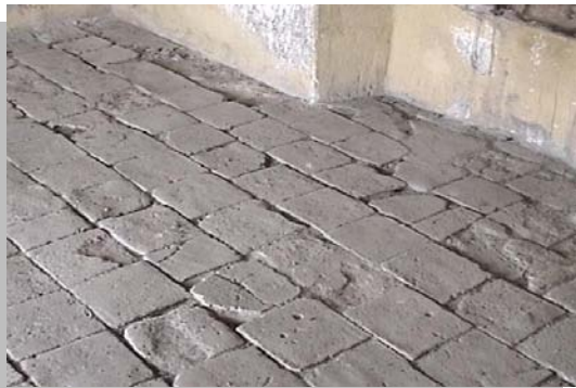
Imagen No. 4.79 Vista de pisos de ladrillo de barro en la crujía norte de la hacienda del Refugio
