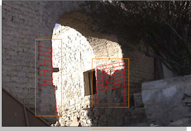
Imagen No. 4.37 Vista de las pilastras que sostienen el arco de acceso entre los dos patios de la Hacienda del Refugio
