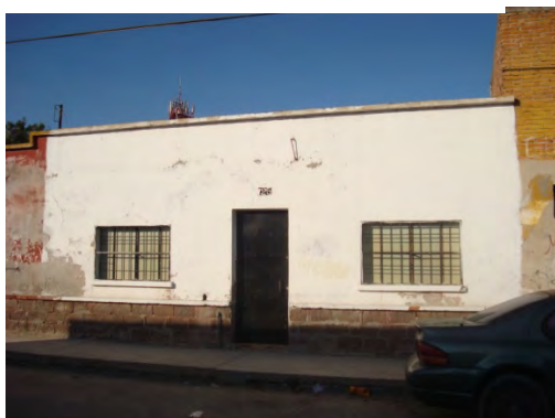
Figura 86. Fotografía tomada por ARV en octubre de 2009, de la vivienda ubicada en C. Abeto #125, perteneciente a la subdivisión del lote 8, de la figura 84.
