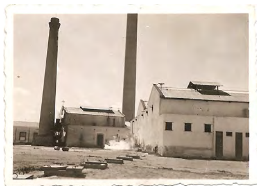
Figura 25. Fotografía tomada del AVC. Vista lateral con vista hacia el sur del conjunto donde se pueden observa las dos chimeneas y un área de menor tamaño del área de producción 3.
