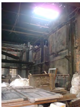
Figura 24. Fotografía tomada por ARV en noviembre 2011. Interior de las tres calderas, en la actualidad dos puertas fueron vendidas al kilo, junto a estas se encuentra la cuarta caldera.
