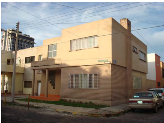
Figura 65. Imagen tomada por ARV en julio de 2011. Donde podemos observar otro ejemplo de las viviendas destinadas para la renta realizadas por Vilet en la Colonia Moderna en la calle Francisco de P. Mariel número 165
