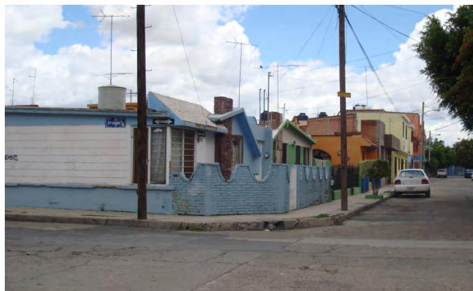
Figura 88. Fotografía tomada por ARV en julio de 2010, Vivienda de la tercer etapa de construcción de la Colonia Industrial.
