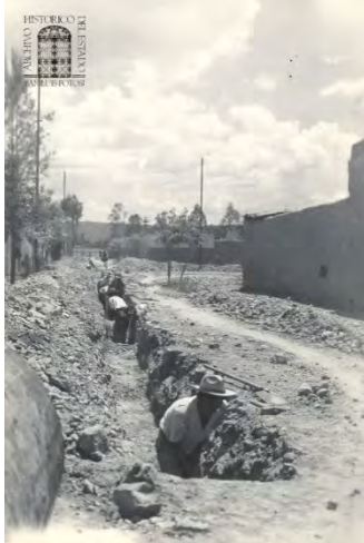
Figura 91. Imagen del Archivo Histórico del Estado, Colector en la colonia Industrial Mexicana: excavación de 1946. Se puede apreciar algunas viviendas de adobe correspondientes a los obreros y el alumbrado.
