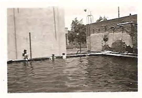
Figura 32. Imagen perteneciente a AVC, tomada desde la alberca privada, hacia el fondo se ven los tanques elevados y hacia la izquierda de la imagen esta el muro del frontón, a la derecha el muro de una de las bodegas
