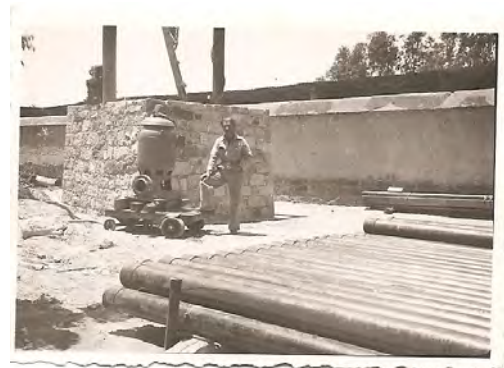
Figura 31. Imagen obtenida del AVC. Pozo junto a la alberca de los dueños, posiblemente la tubería de la fotografía era para la instalación hidráulica de la fábrica.
