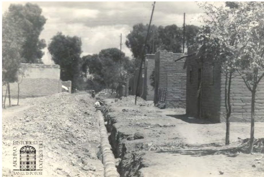
Figura 80. Imagen obtenida del Archivo Histórico de San Luis Potosí, donde se puede apreciar la fisonomía de las casas de los obreros, hechas de adobe y las cubiertas de lamina
