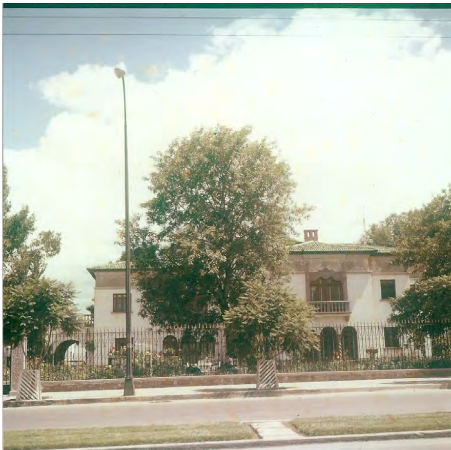
Figura 66. Imagen obtenida de AVC. Residencia de la familia Vilet Compeán ubicada en Av. Venustiano Carranza 1805, construida aproximadamente a principios de la década de los cuarenta para la familia Villalobos y después de estar abandonada un par de años es comprada por José Vilet Brullet. Ubicada a mitad de la avenida y que en un inicio era de lo más alejado de la ciudad.
