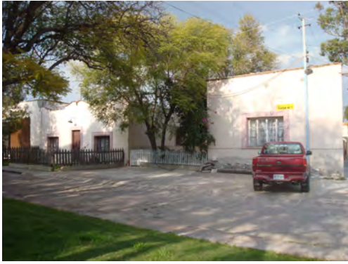
Figura 41. Fotografía tomada por ARV en noviembre de 2009. Par de viviendas para empleados de confianza al norte de la fábrica.
