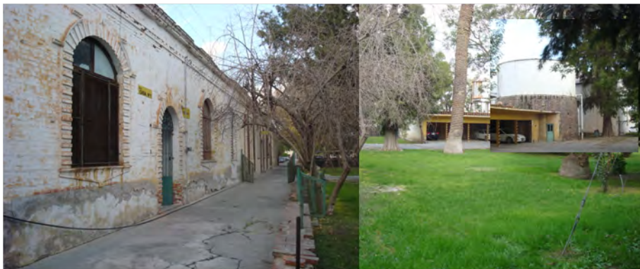
Figura 29. Fotografías tomadas por ARV en Noviembre 2009, montaje del conjunto de área privada en la España Industrial
