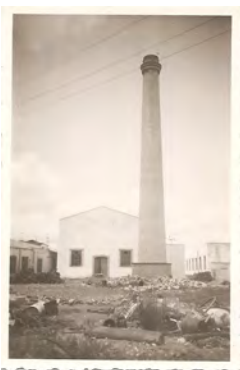
Figura 21. Fotografía tomada del AVC. Primer chimenea del conjunto, en la parte posterior se ve el cuarto de calderas.
