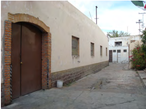
Figura 38. Fotografía tomada por ARV en noviembre del 2009. Pasillo distribuidor de los servicios a la izquierda se observa el acceso al taller mecánico y al fondo se ven los sanitarios.
