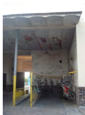
Figura 35. Fotografías tomadas por ARV en Noviembre 2009. Vista del área de acceso de los obreros y estacionamiento de bicicletas.
