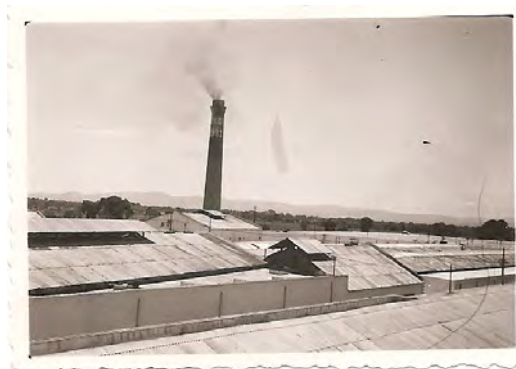
Figura 23. Fotografía tomada del AVC. Primer chimenea del conjunto vista desde la azotea del Volumen de dos niveles.
