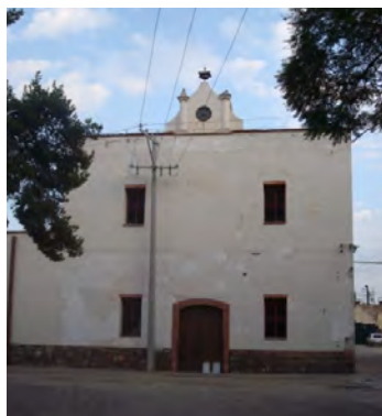
Figura 13. Fotografía tomada por ARV en noviembre 2009, edificio de dos niveles, en la España Industrial
