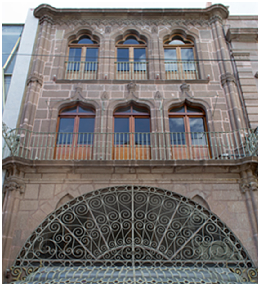
Fotografía 28 Fachada ubicada en Calle Hidalgo # 233 Fotografía: Mtro. en H. Sergio Serrano Hernández.
