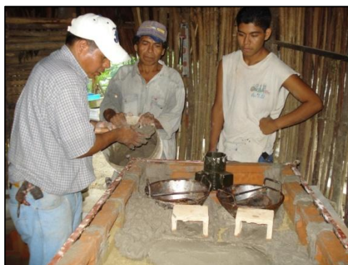
Figura 5. Construcción de estufas.
