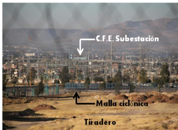
Foto 4.8: Vista del tiradero y subestación de luz. Sandra Flores 2010.
