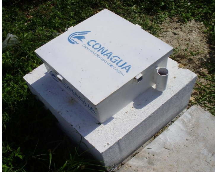
Figura 3.3: Banco de nivelación y la protección instalada en los pozos perforados.
