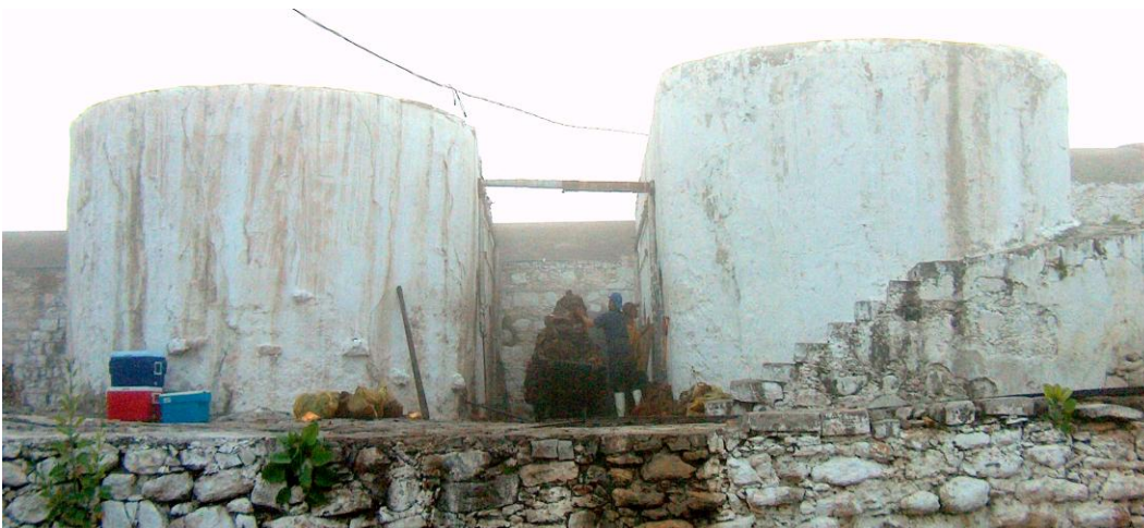
Fig. 2.8. Hornos elevados de mampostería abovedados. En la derecha destaca la escalinata de acceso al techo y en el fondo se aprecia la bóveda de la cámara de fermentación.
