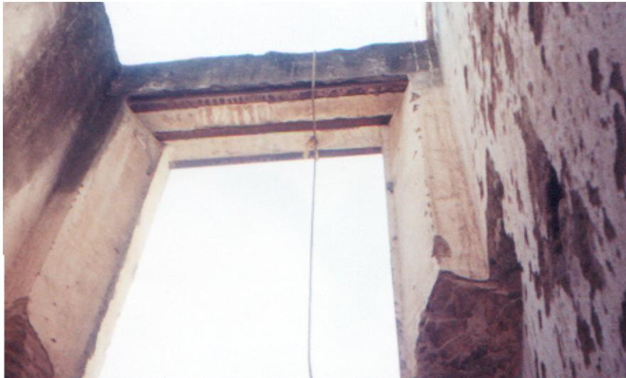
Los entrepisos y azoteas se construyeron con un material nuevo: acero traído por tracción animal desde Río Verde, S.L.P. y el sistema consistía en un acomodo de vigas “I” a una cierta distancia dictada por el ancho de las laminas en forma de arco cañón, luego se nivelaba con mezcla y se colocaba un terrado con tizar por ultimo se colocaba ladrillo de cuadro o mosaico pegado con mezcla de cal y arena:
