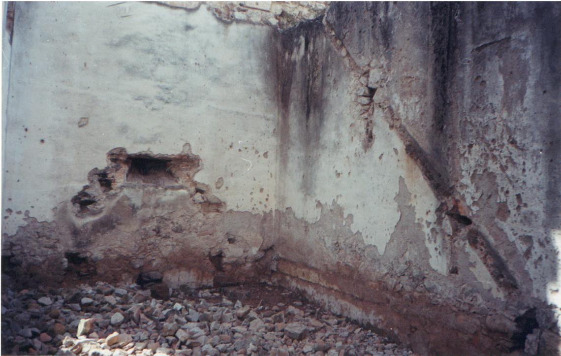
Esta foto muestra el único espacio que se puede reconocer como cocina ya que en éste existe un tiro de chimenea que esta forjado de ladrillo y que forma parte integrante del muro y que se construyó ex profeso, es decir que no fue adosado o agregado después, inclusive esta salida del horno (del cual se puede observar parte de su forma en la pared) fue la pauta para el diseño de las ventanas de esta fachada.
