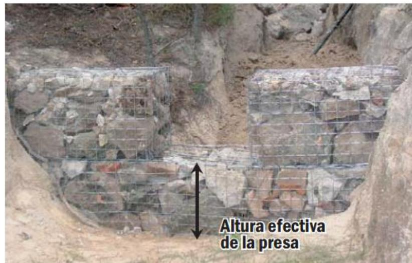
Figura 15. Presa de alambre o malla electrosoldada. Fuente: CONAFOR, 2007.
