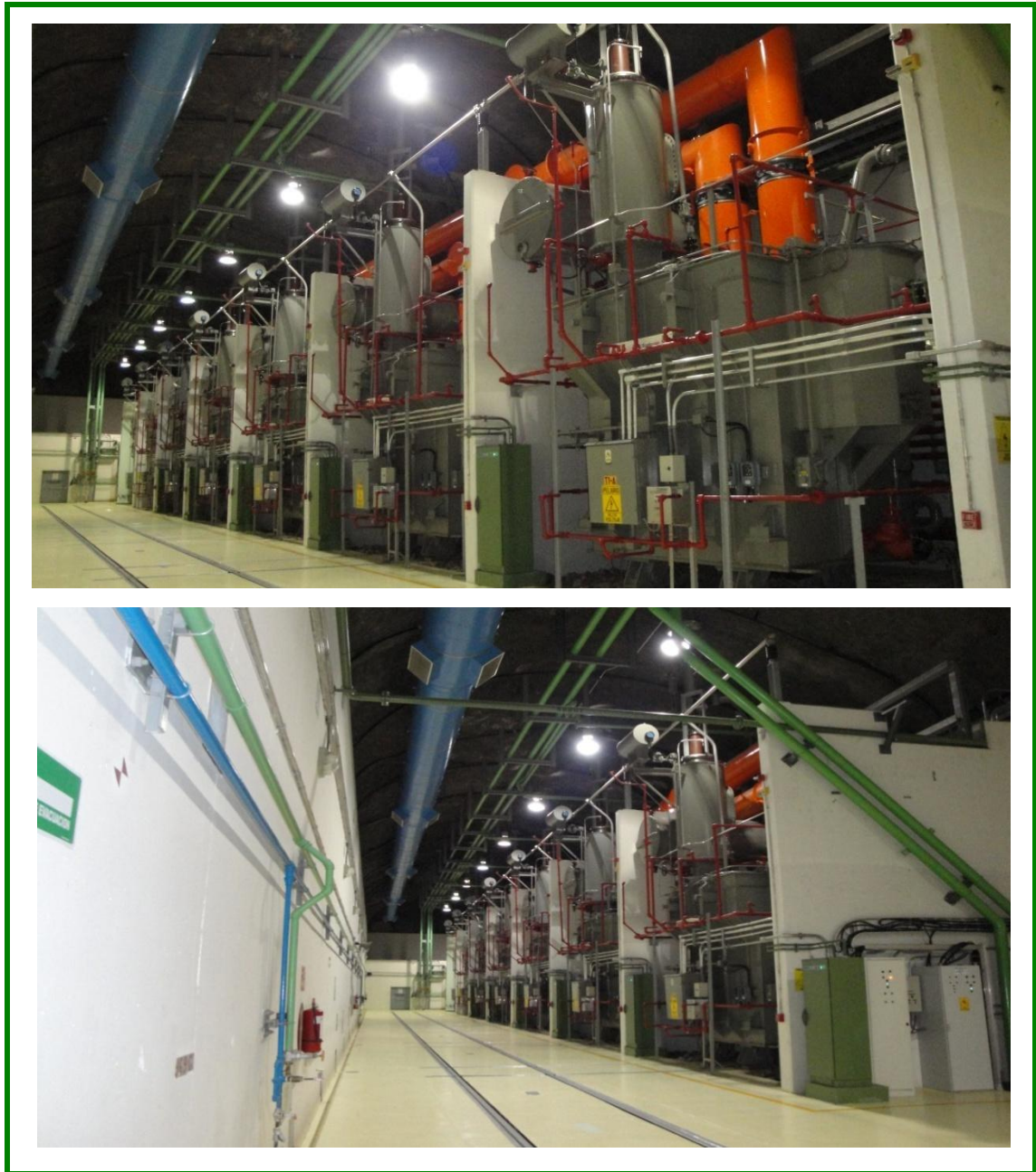
Figura 8. Galería de Transformadores
