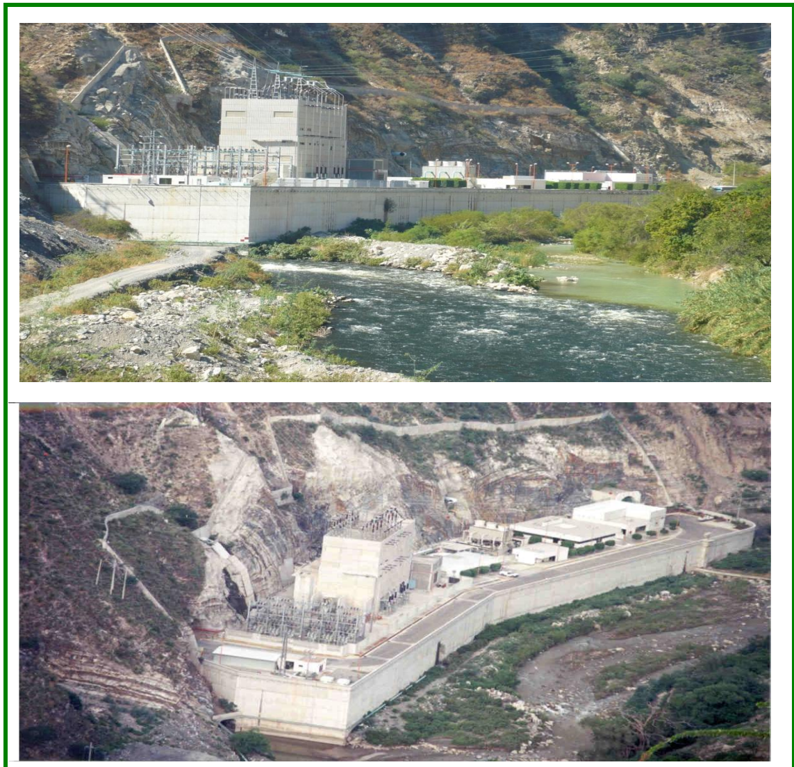
Figura 5. Vista panorámica de Casa de Máquinas
