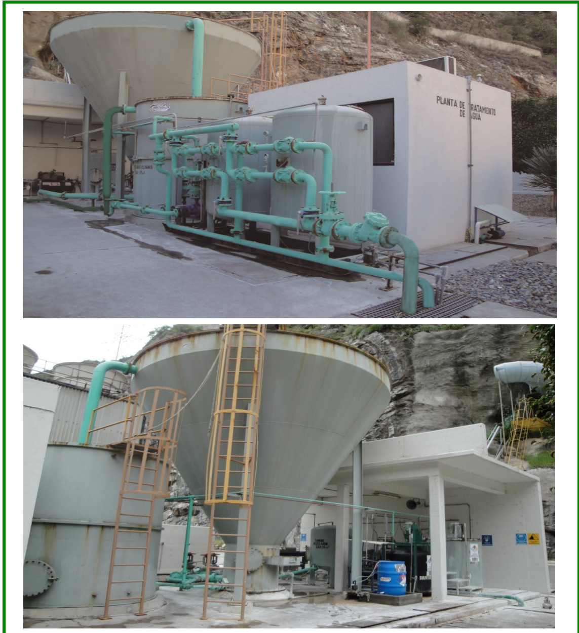
Figura 11. Planta de tratamiento de agua
